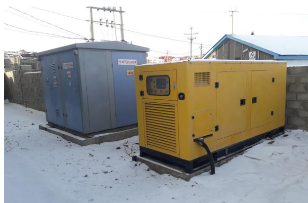
Цахилгааны генератор /халаалтыг цахилгаанаар шийдсэн эх үүсвэр/
