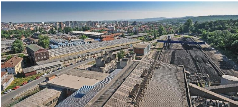
Slika 42. Panoramski prikaz kompleksa sa južne strane kompleksa -pogled na pepelište-deo zone 3.2 i deo objekta toplane-zona 4.2 (krupni plan)
