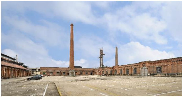
Slika 62. Dimnjak stare kotlare
