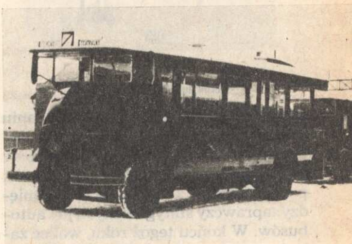
Autobus „Somua” z nadwoziem PZInż – widok z przodu
