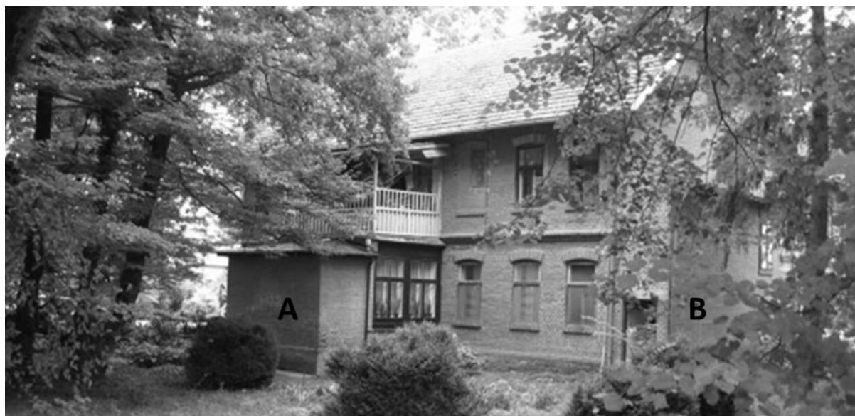
PRILOG 4. Zatečeno stanje. Pogled na zapadno pročelje s terasom. A) Kasnija adaptacija na nekadašnjoj verandi. B) Kasnija adaptacija na južnom pročelju.
