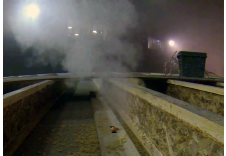
(b) Stud Bay Exhaust With Fan
