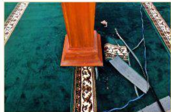
Pemotongan coakan tiang dengan rapi & presisi
