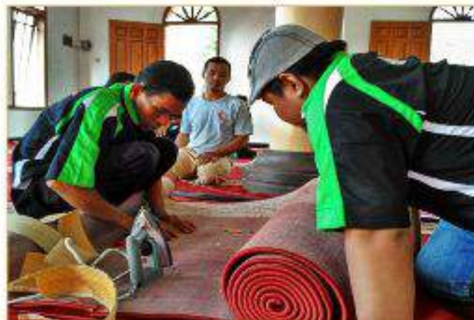
Proses Penyambungan dengan lem khusus
