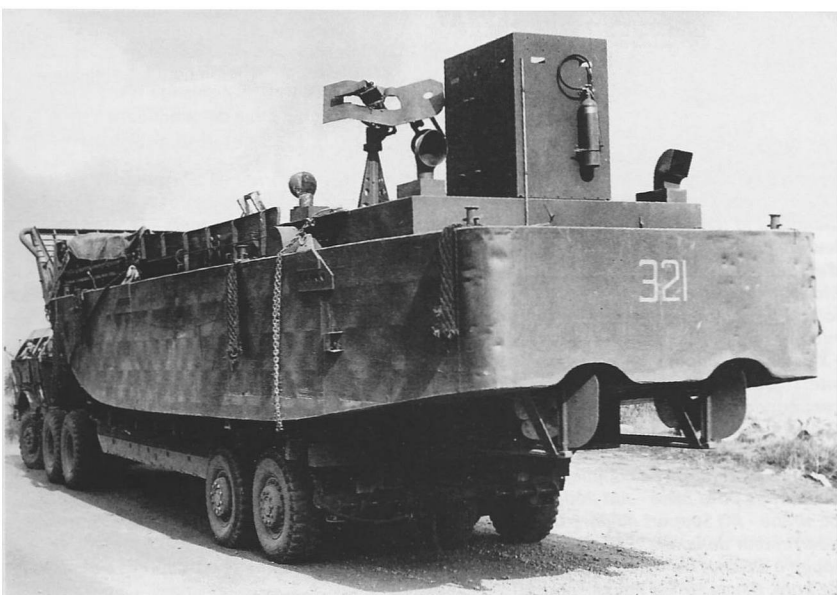
Ci-dessous. Mars 1945, région de Maastricht, Hollande. Un M26 transporte un LCM en prévision des opérations de traversée du Rhin. Le tracteur avec sa remorque semble petit par rapport au volume transporté mais il n'est pas en surcharge, le LCM ne pesant que 26 tonnes. Une série de poutres en bois sont installées sur la remorque pour maintenir la barge. (Photo NARA)
