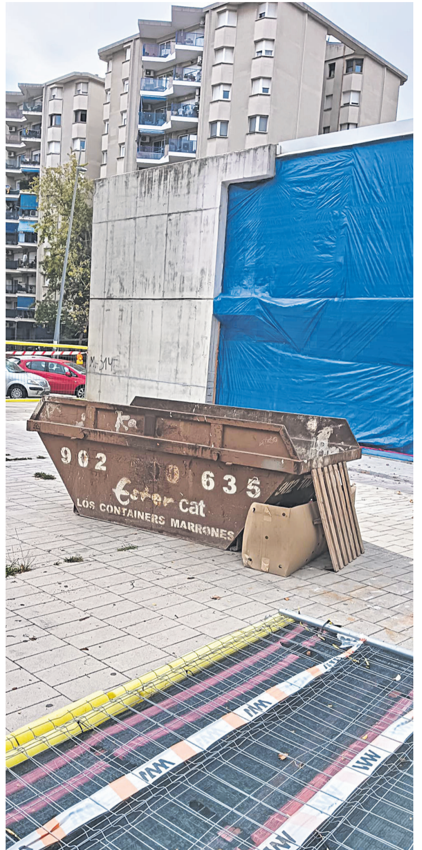
Una imatge de les obres al CAP Concòrdia / CEDIDA
