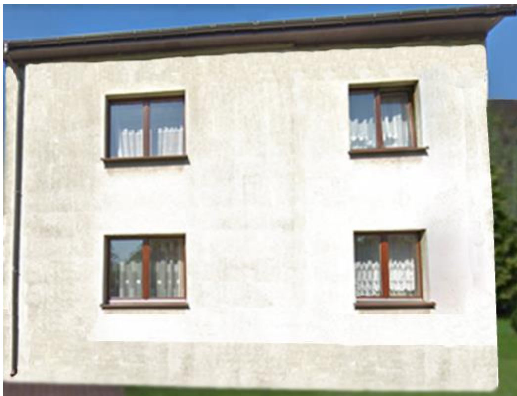
Z5_Rys. 99. Zdjęcie budynku wchodzącego w skład osłony kontrolnej OKW9 210
