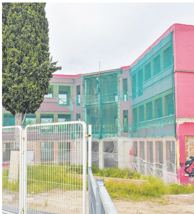
Imatge de l'edifici, en obres, fa poc més d'un any / LLUÍS FRANCO
