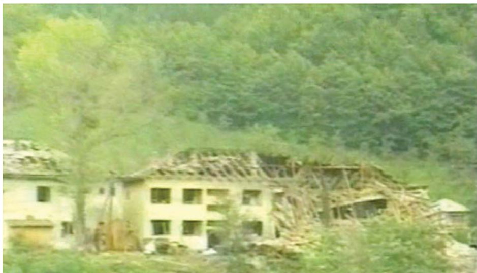
Слика 9. Уништена стамбена зграда у Србињу
