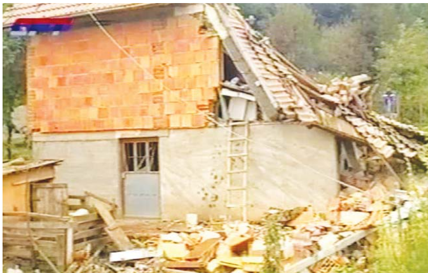
Слика 42. Уништен цивилни објекат на подручју Српског Сарајева
