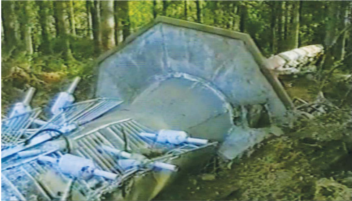
Слика 23. Остаци уништеног радио-релејног центра „Столице“ на Мајевици
