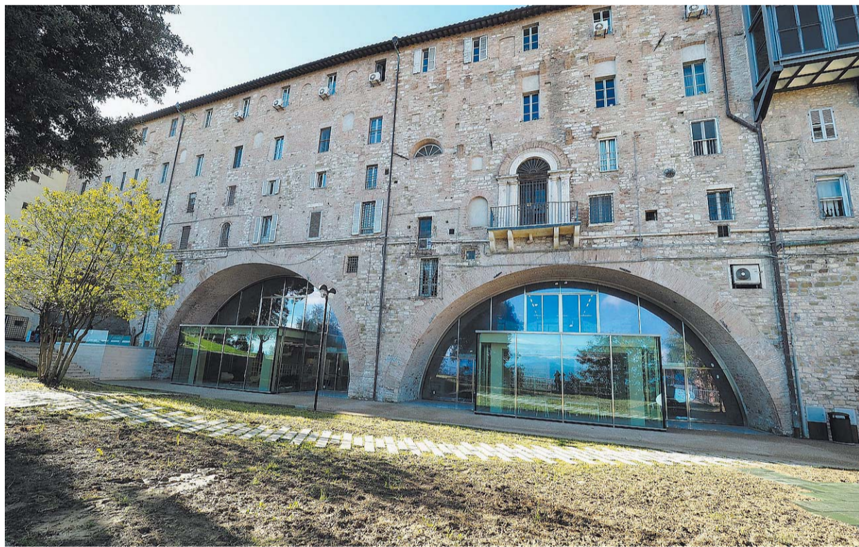
Grandi opere La biblioteca multimediale degli Arconi è arrivata al traguardo. Rimosso il cantiere (Foto Belfiore) → a pagina 11 Sabrina Busiri Vici
