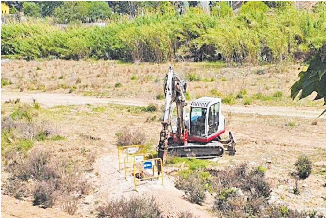
Una màquina excavadora, treballant a la volta del Rec Comtal / ACN
