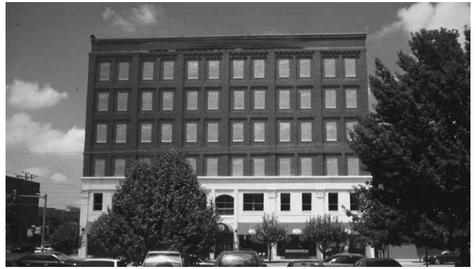
Figura 10.14 Los edificios con pocas o ninguna ventana son difíciles de ventilar. En el edificio de la fotografía, se han tapiado las ventanas por encima de la segunda planta.
