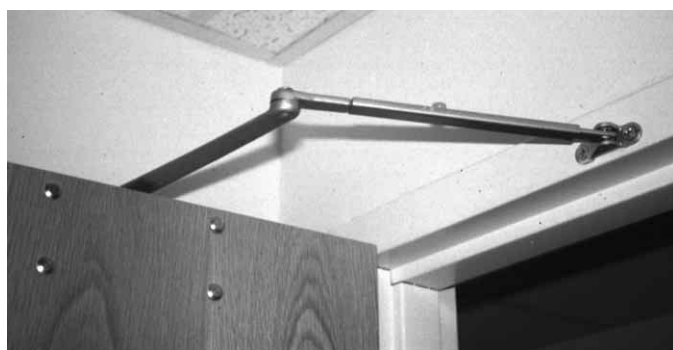
Figura 8.43 Mecanismo de autocierre de una puerta.
