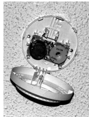
Figura 15.14 El tipo más habitual de detector de humo residencial es el que funciona a pilas.
