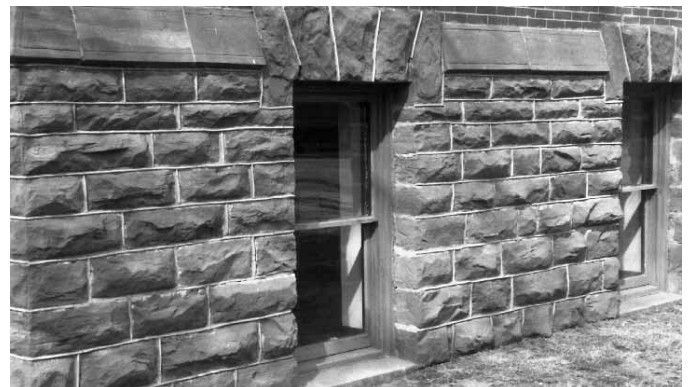
Figura 10.40 Algunas ventanas de los sótanos estarán a la altura de la calle en el exterior del edificio.
