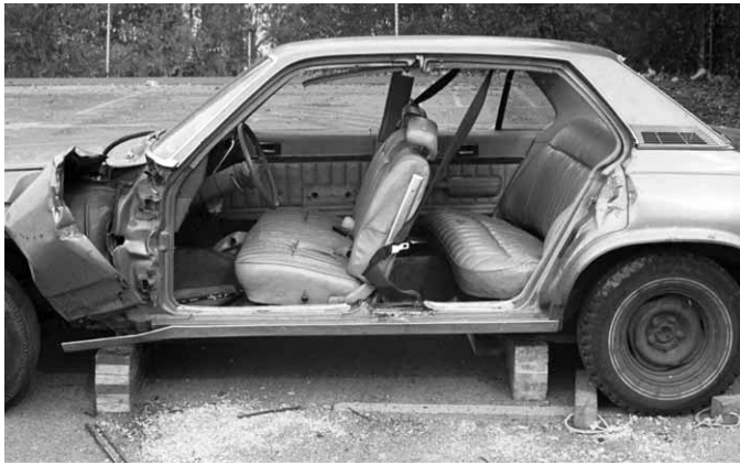
Figura 7.80 Al retirar completamente las dos puertas y la estructura de en medio se conseguirá un acceso total al compartimento de pasajeros.
