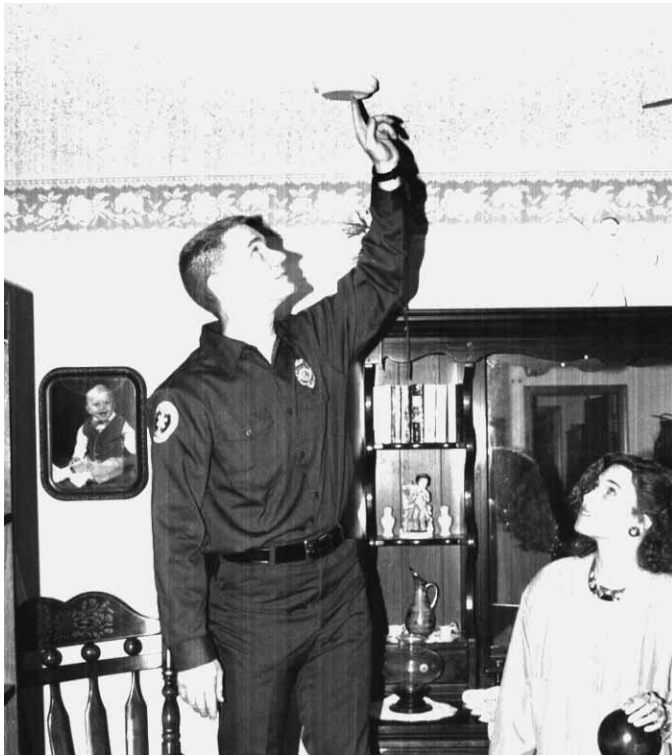
Figura 19.46 Verifique el estado del detector de humo para asegurarse de que funciona correctamente.
