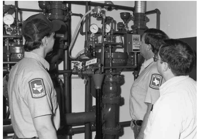
Figura 14.52 El personal de protección contraincendios inspecciona un sistema fijo de extinción.
