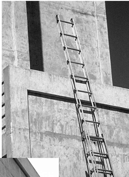
Figura 9.34 Una escala levantada hasta el tejado debe sobrepasarlo al menos en 5 peldaños.
