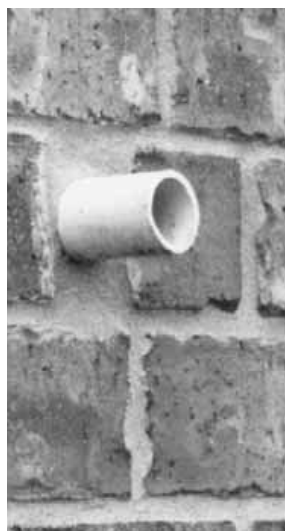
Figura 15.59 Drenaje del sistema residencial de rociadores.
