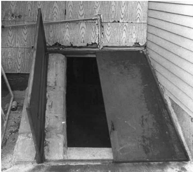
Figura 10.13 Las puertas exteriores de los sótanos suelen ser de acero y difíciles de forzar. Gentileza de Bob Esposito.
