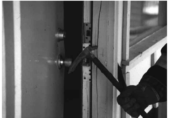
Figura 8.51 Bomberos realizando una entrada forzada convencional a través de una puerta.
