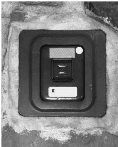
Figura 8.50 Las cajas de llaves exteriores proporcionan un medio de entrada no destructivo.
