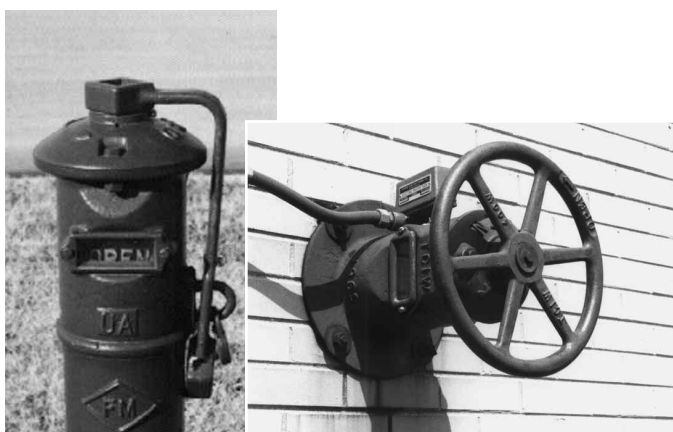
Figura 15.44 Válvula de seguridad indicadora de pared.
