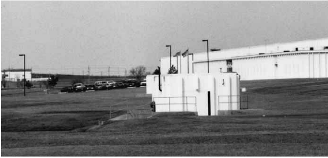
Figura 11.6 Abastecimiento de agua privado de una industria.
