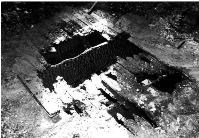
Figura 17.11 El fuego se propaga más rápido por una estructura si el suelo está agujereado.
