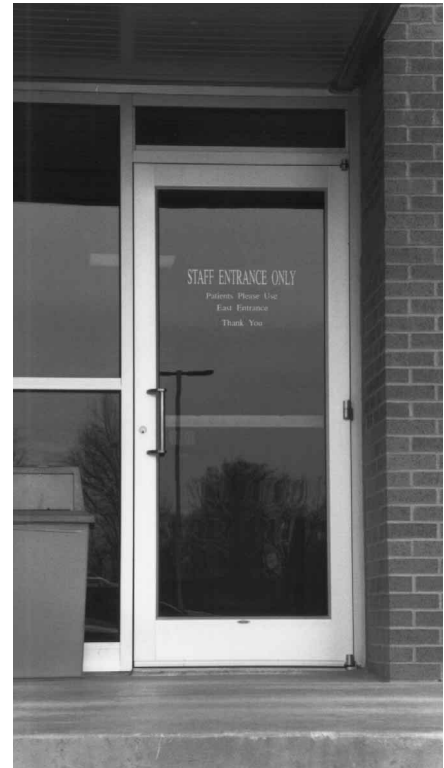
Figura 8.57 Las puertas con plafones de vidrio templado suelen tener marcos metálicos.
