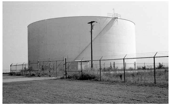
Figura 11.2b Los tanques de almacenaje a nivel del suelo pueden suministrar grandes cantidades de agua a las actuaciones contraincendios.
