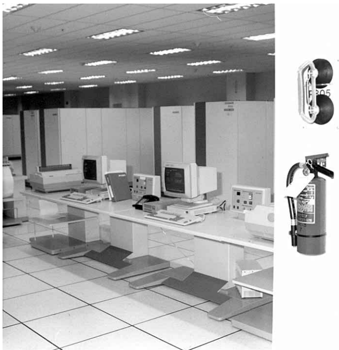
Figura 5.31 Los extintores de halón se utilizan para áreas con ordenadores.
