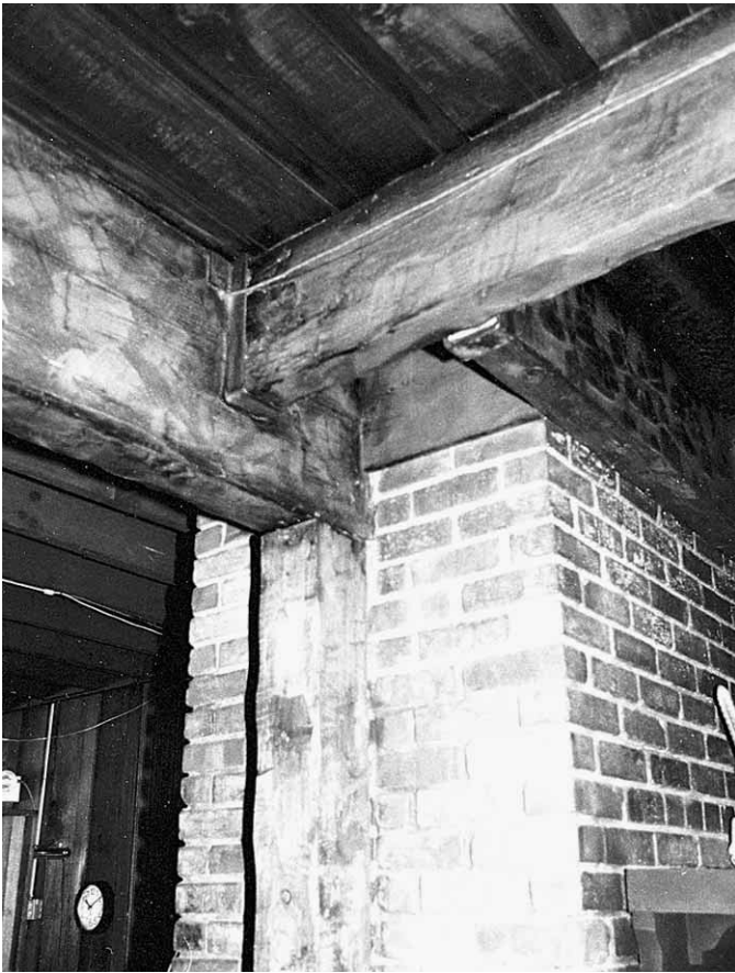
Figura 3.5 Construcción de tipo IV. Gentileza de Keith Flood.
