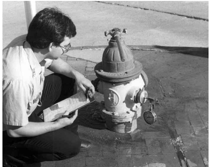
Figura 11.18 La presión residual de un hidrante se mide mientras se descarga el agua de otro hidrante.
