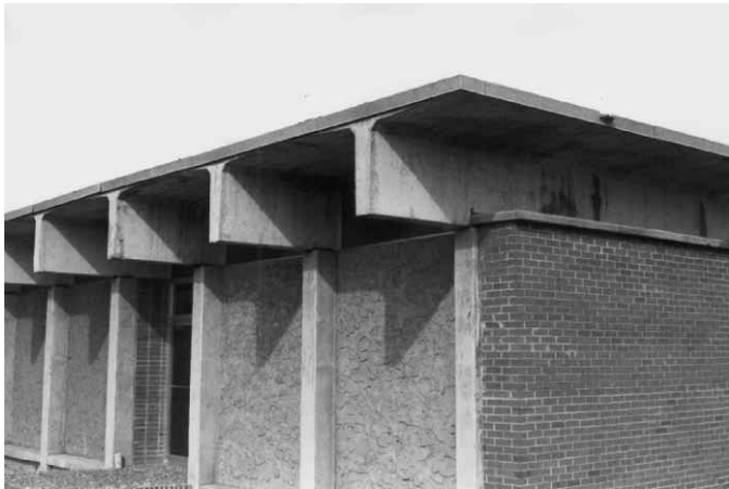
Figura 10.36 La mayoría de los tejados de hormigón son prefabricados.
