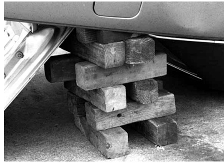
Figura 7.73 Puede ser necesario construir pilares de caja altos para estabilizar vehículos volcados.
