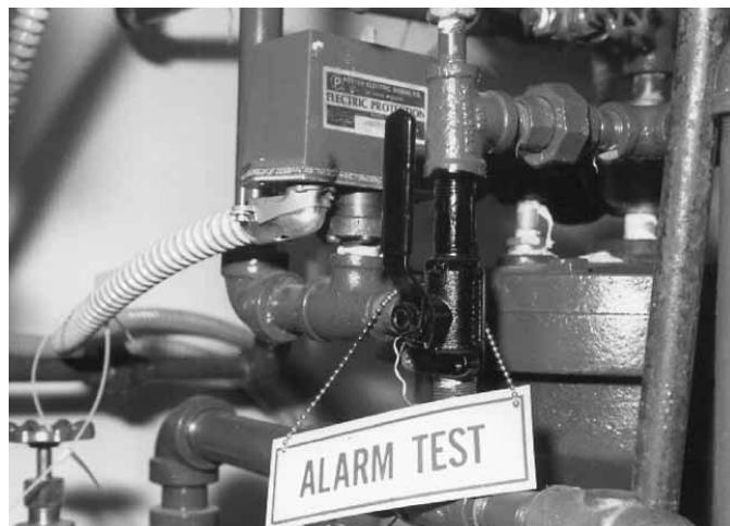
Figura 15.46 Válvula de prueba con giro de 90°.
