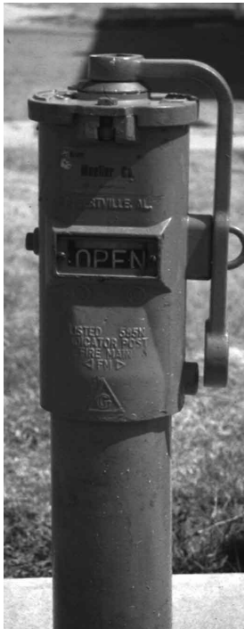
Figura 11.11 Las válvulas de seguridad muestran claramente si el abastecimiento de agua está activado o no.
