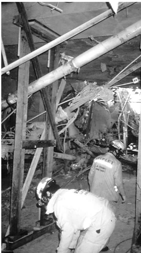
Figura 7.97 Sistema de apuntalamiento instalado.
