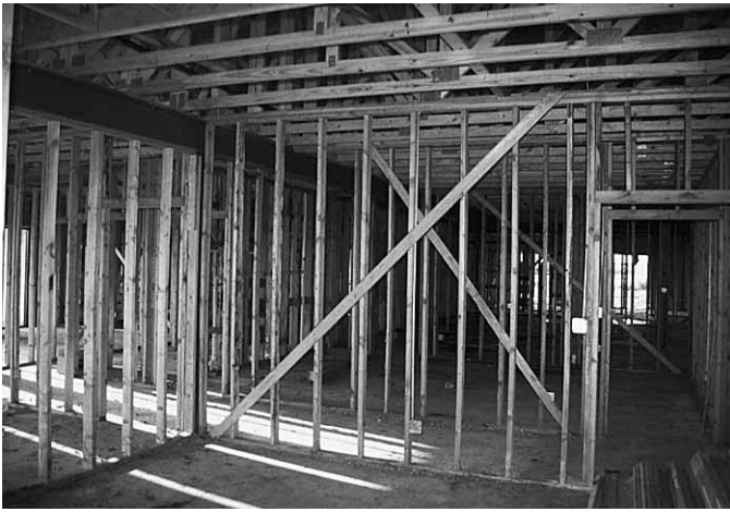
Figura 3.6 Construcción de tipo V.
