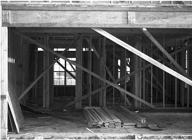
Figura 3.30 "Esqueleto" de un edificio de madera en construcción.
