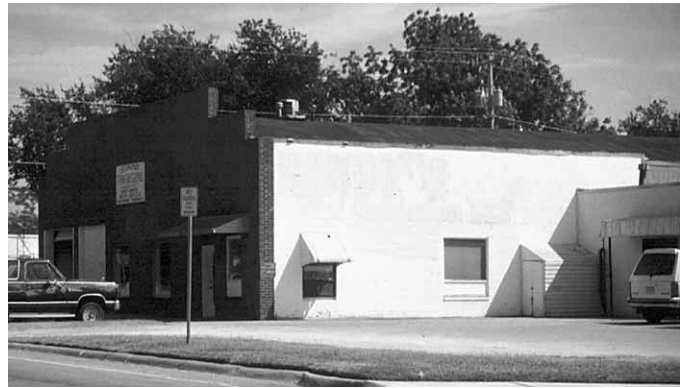
Figura 3.29 La forma redonda indicadora de un tejado de armadura de arco y puerta puede ocultarse tras parapetos de punta cuadrada.
