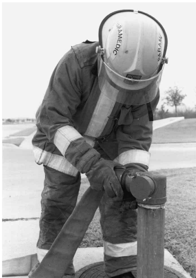
Figura 15.61 Bombero conectando el autobomba a la conexión del cuerpo de bomberos.
