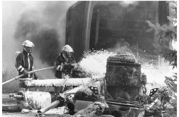
Figura 13.36 Es importante que el dosificador y el dispositivo de liberación se correspondan para producir espuma útil.
