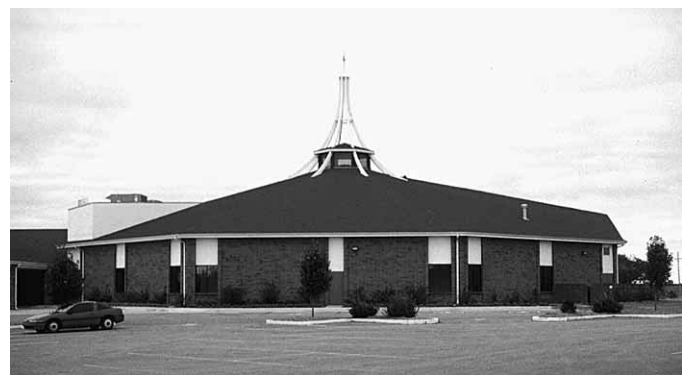
Figura 3.20 Los edificios con grandes espacios abiertos arden rápido y, en muchos casos, se hunden rápidamente.
