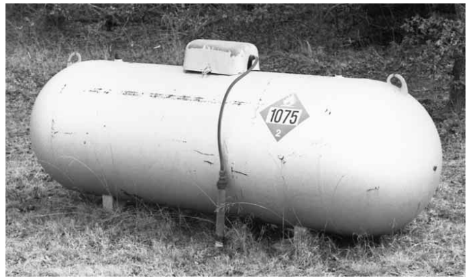
Figura 14.26 Un gran número de instalaciones utiliza gases combustibles almacenados en cilindros en su propiedad.
