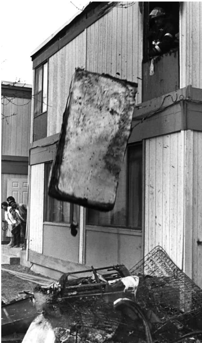
Figura 17.2 Los materiales revisados suelen apilarse fuera de la estructura.
