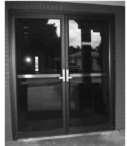
Figura 8.28 Típica puerta metálica tubular rectangular.
