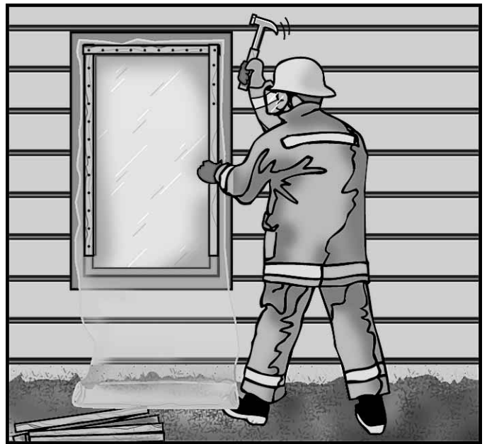
Figura 16.24 Las ventanas pueden recubrirse con plástico para proteger temporalmente el interior de las inclemencias del tiempo.
