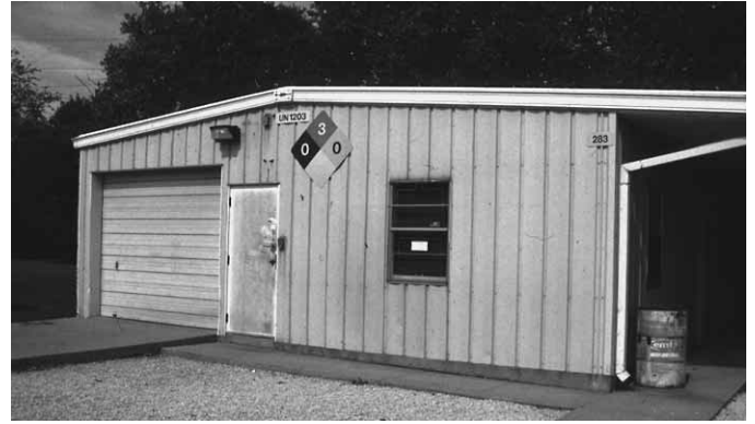
Figura 8.84 Un gran número de edificios de reciente construcción tienen muros exteriores de metal.
