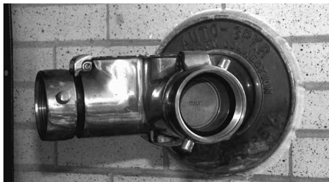
Figura 15.50 En esta conexión al cuerpo de bomberos, se puede observar la válvula de bisagra.
