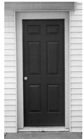
Figure 8.24 Las puertas de panel de madera están fabricadas con elementos de madera sólidos que rodean a cristal, plástico o paneles de madera.
