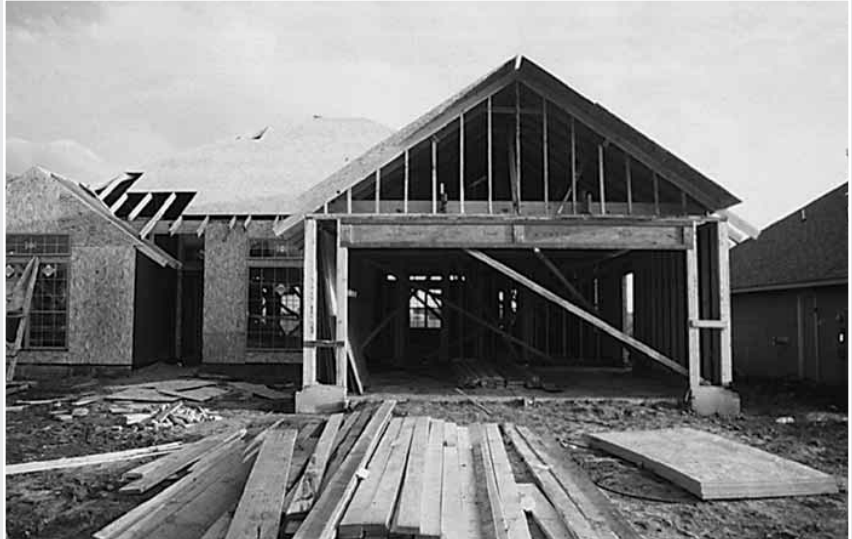
Figura 2.13 La madera apilada delante de esta casa al igual que sus elementos estructurales son ejemplos de paquetes de combustible.
