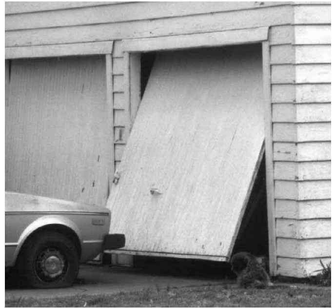
Figura 8.36 Puerta de garaje sólida. Observe que en las actuaciones de entrada forzada, puede que no se pueda abrir esta puerta a menos que no se quite el automóvil de delante de ella.
