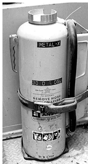
Figura 5.21 Extintores de la clase D de mano y ruedas.
