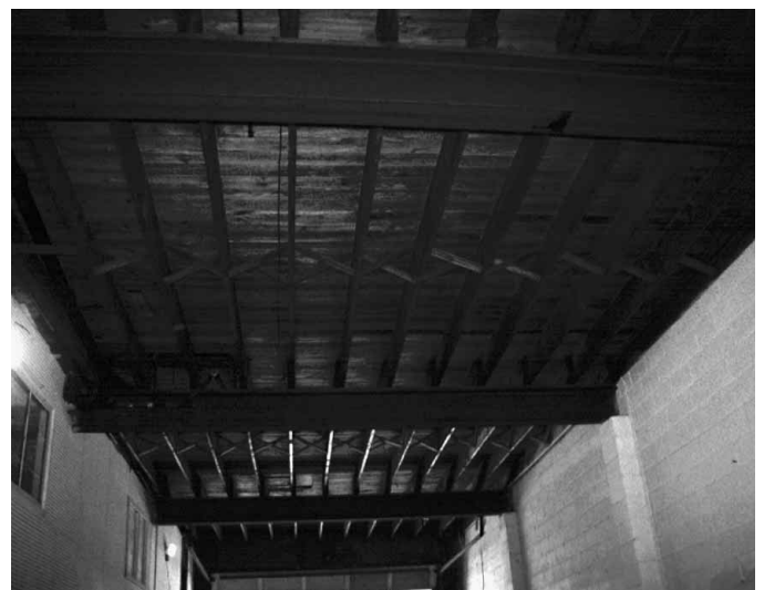
Figura 3.4 Construcción de tipo III.
