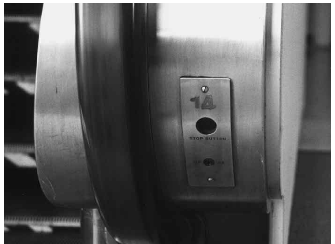
Figura 7.114 La mayoría de escaleras mecánicas tienen controles de parada de emergencia.
