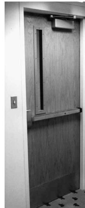
Figure 8.45 Puerta de incendios batiente típica.
