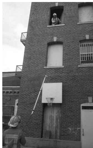
Figura 6.20 Se utiliza un cable de cola para evitar que la herramienta choque contra la esquina del edificio.
