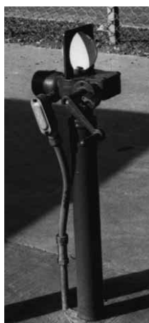
Figura 15.45 Los ensamblajes de válvulas de seguridad indicadoras utilizan válvulas de mariposa en vez de válvulas de compuerta.
