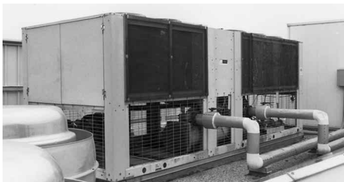
Figura 14.4 Los miembros del equipo deben estar alerta por si existen condiciones potencialmente peligrosas como equipo mecánico pesado sobre el tejado.
