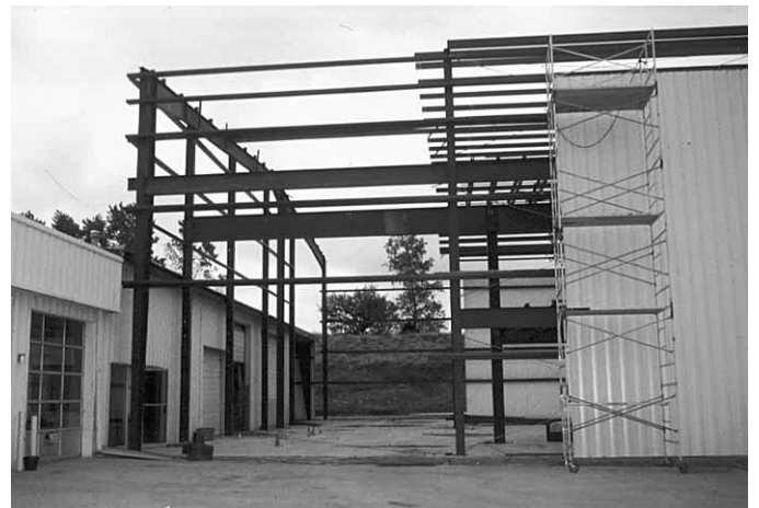
Figura 3.12 Una superestructura de acero típica.
