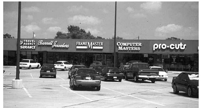
Figura 3.25 Una construcción de armaduras ligeras puede ser extremadamente peligrosa para los bomberos durante su actuación.
