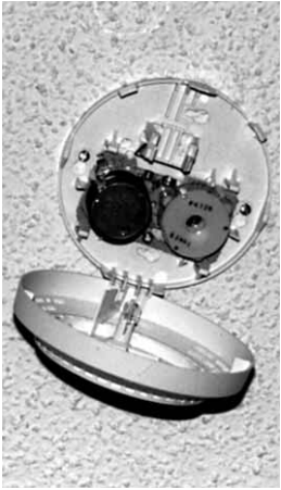
Figura 17.12 Puede haberse desconectado un detector de humo para retrasar la detección del incendio.
