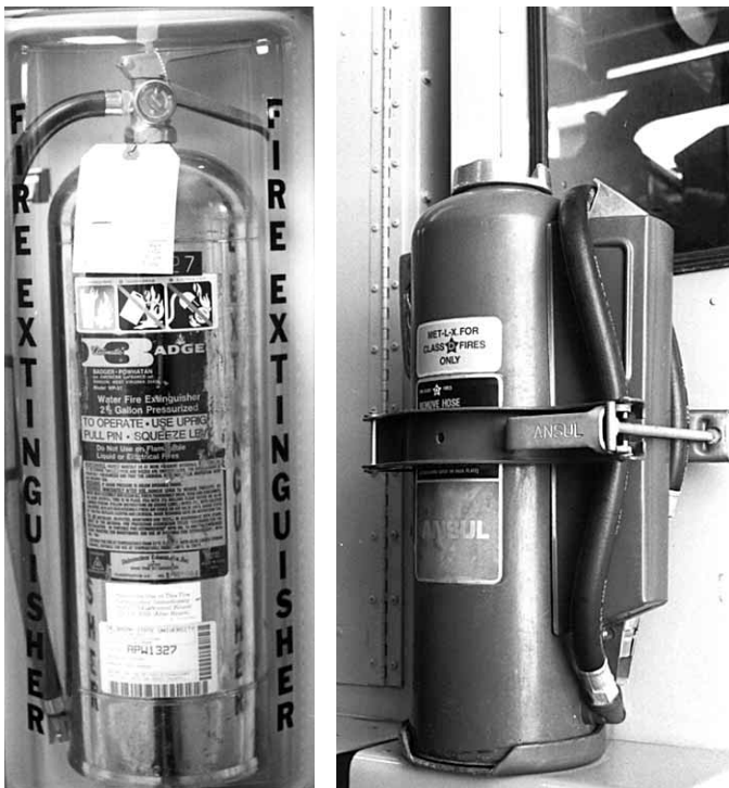
Figura 5.1 Los extintores de incendios pueden situarse en posiciones fijas en una instalación o montados en un vehículo.
