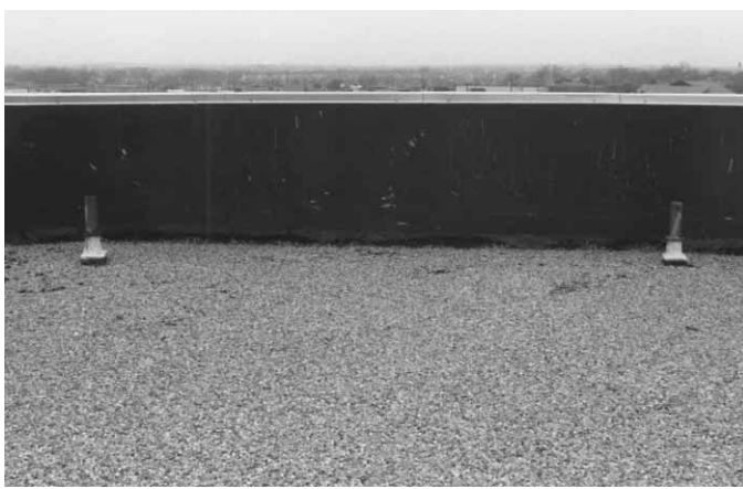
Figura 10.32 El tejado plano suele estar traspasado por conductos de ventilación.
