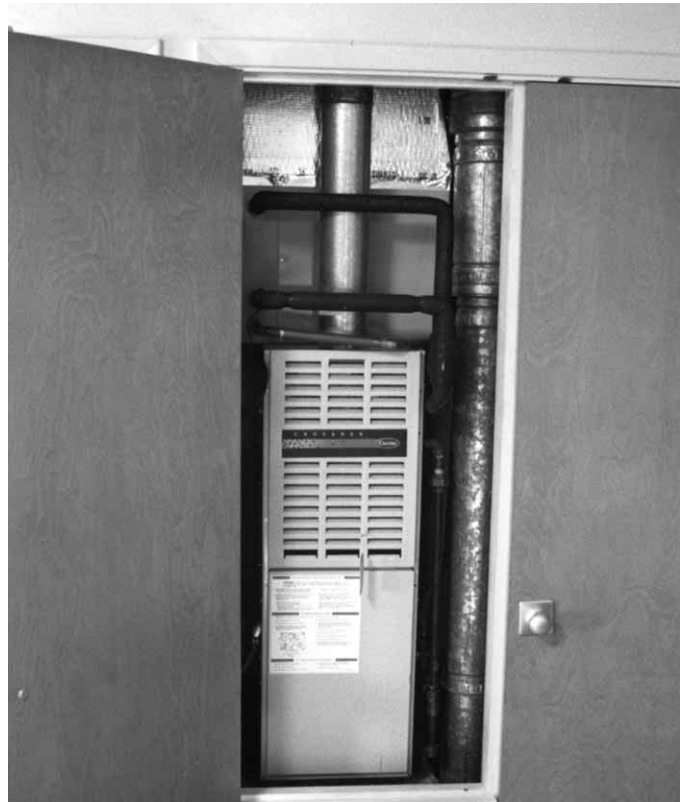
Figura 19.30 Compruebe si existen problemas evidentes en el sistema de calefacción.
