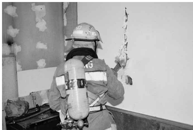
Figura 8.81 Cuando realice una abertura en un muro, corte el recubrimiento del muro a lo largo de los travesaños.
