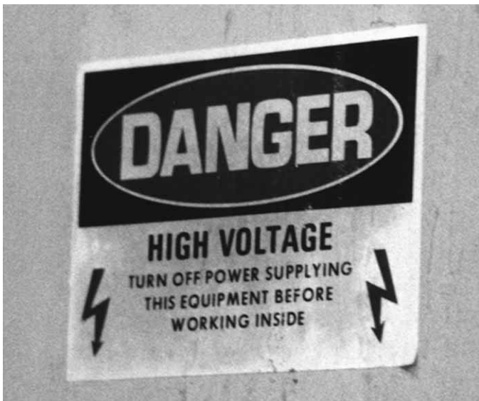
Figura 14.33 Extreme las precauciones cuando entre en habitaciones que contienen equipo de alto voltaje.
