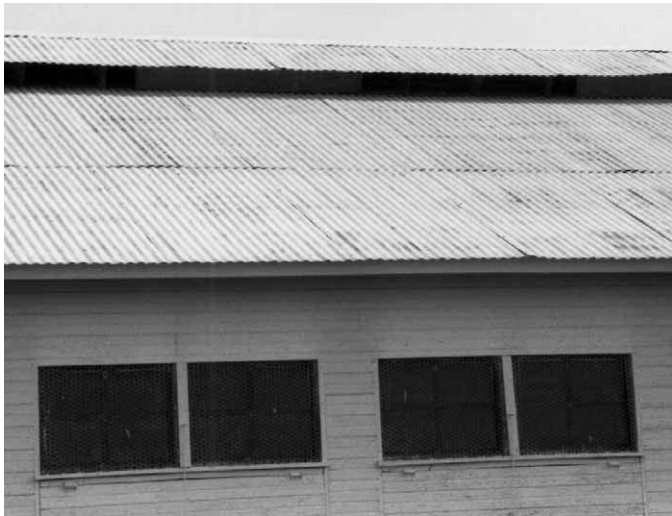
Figura 10.37 Tejado con chapa metálica ondulada.
