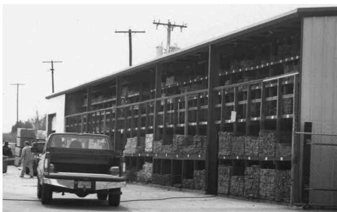
Figura 19.16 Las instalaciones peligrosas exigen una atención especial durante las inspecciones de prevención de incidentes.
