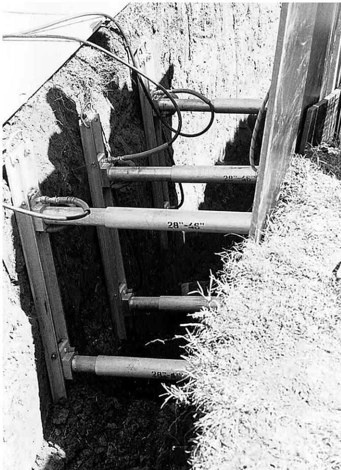
Figura 7.99 Apuntalamientos hidráulicos de aluminio que estabilizan una zanja.
