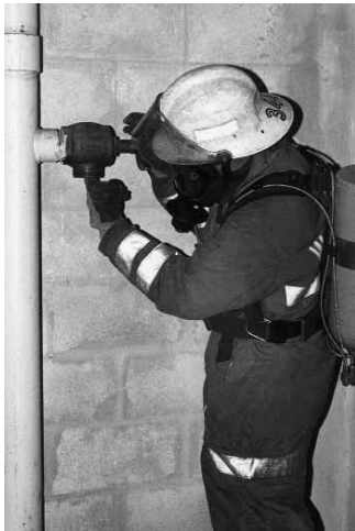
Figura 12.85a Compruebe la descarga para verificar que no hay suciedad.
