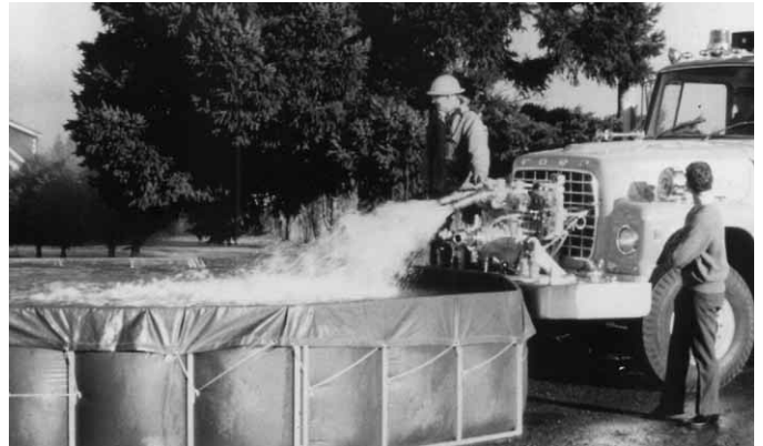
Figura 11.37 Los conformadores de corriente se utilizan para garantizar que toda el agua va en dirección al tanque portátil. Se utilizan principalmente cuando se bombea agua fuera del vehículo.
