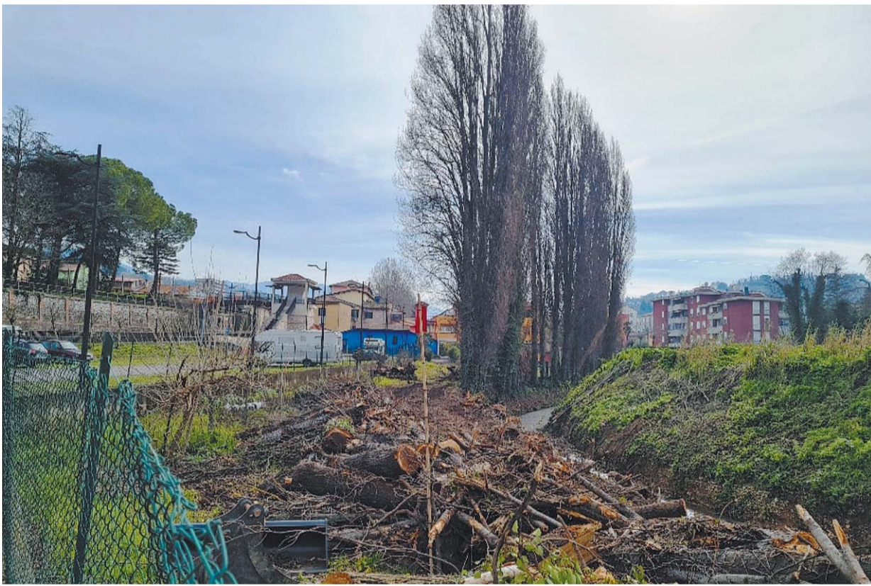
Consorzio di bonifica Tevere-Nera L'ente si sta occupando dei lavori di messa in sicurezza del fosso di Stroncone al quartiere San Valentino
