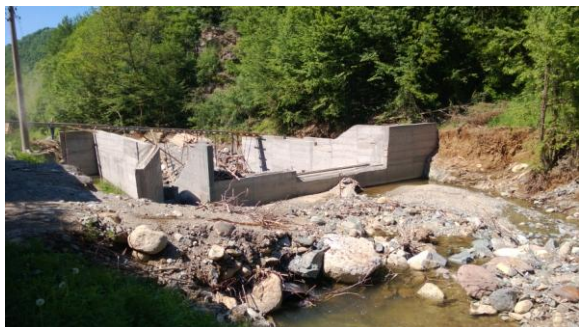
Slika 1. Vodozahvatna građevina na Crnovrškoj reci (Park prirode "Stara planina"), april 2018.
