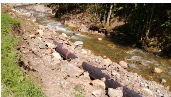
Slika 2. Derivacioni cevovod u koritu Crnovrške reke (Park prirode "Stara planina"), april 2018.
