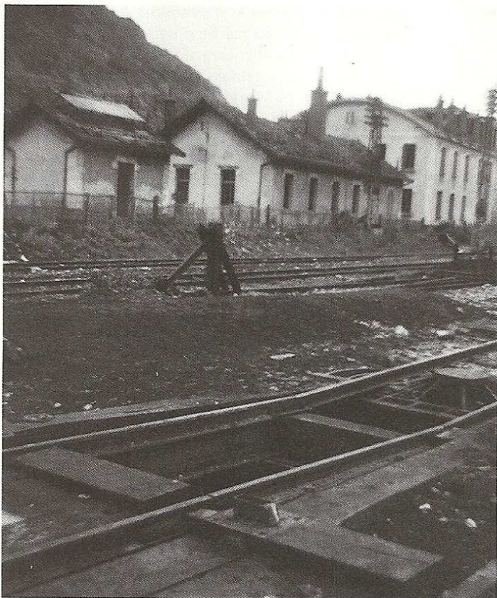
▲ La plate-forme du 340 B s'est affaissée lors des tirs du 24 juin 1940. Le souffle des obus de 340 a fait souffrir les toits de la douane italienne. Les artilleurs vont démonter la plate-forme et se replier d'abord en Isère puis à Livron, où ils seront démobilisés.
