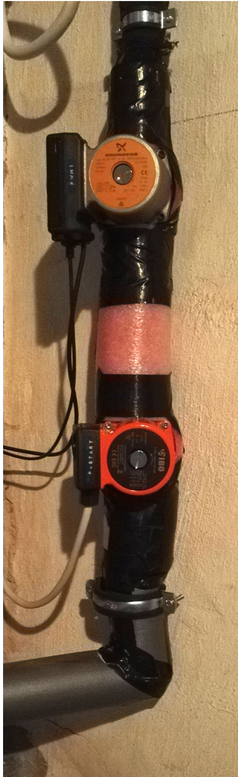
Die Pumpen nun isoliert.
