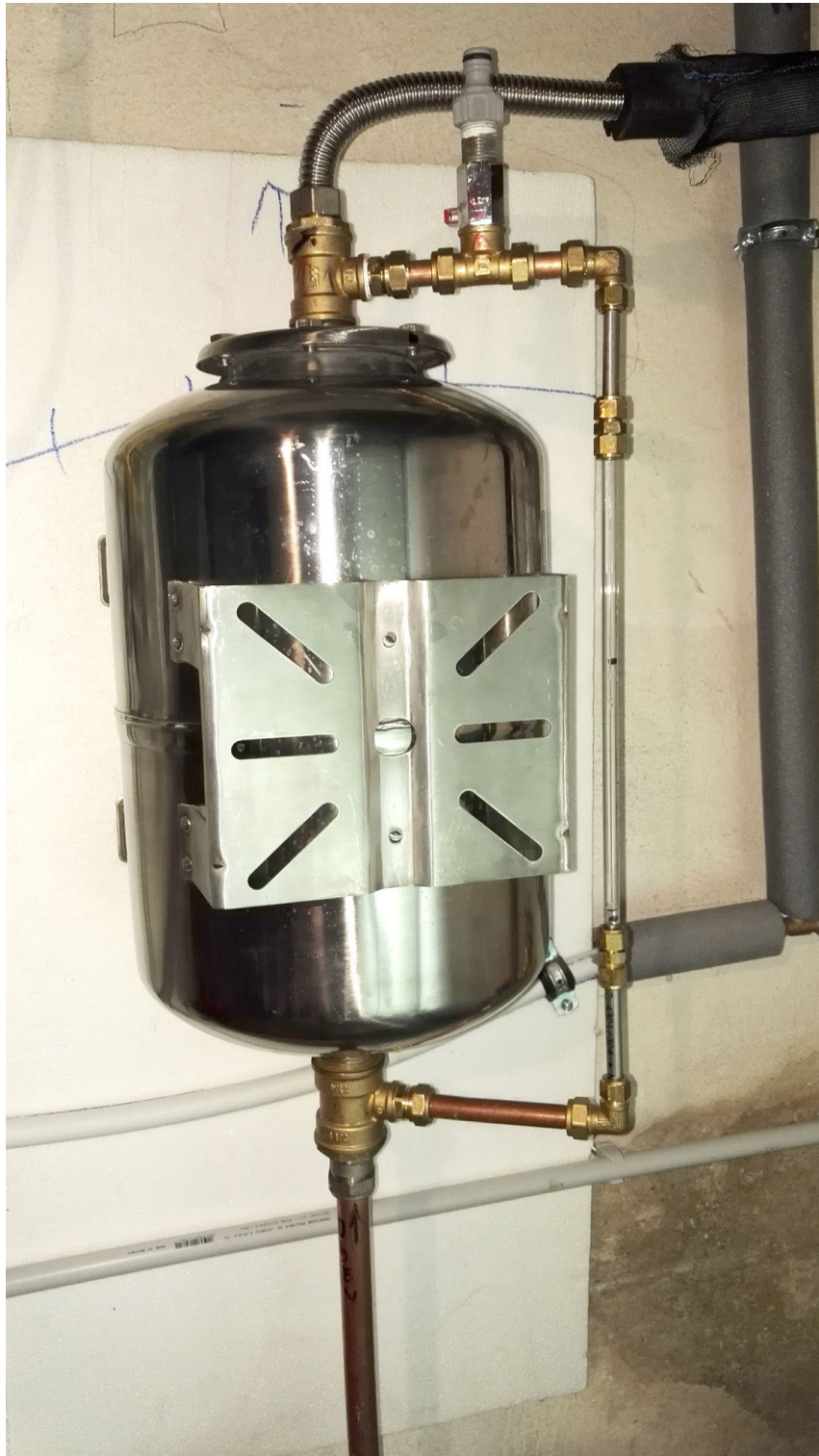
Der DrainBack Behälter Marke Eigenbau aus einem Edelstahl MAG, verrichtet jetzt gluckerd seinen Dienst. Hier noch unisoliert.
