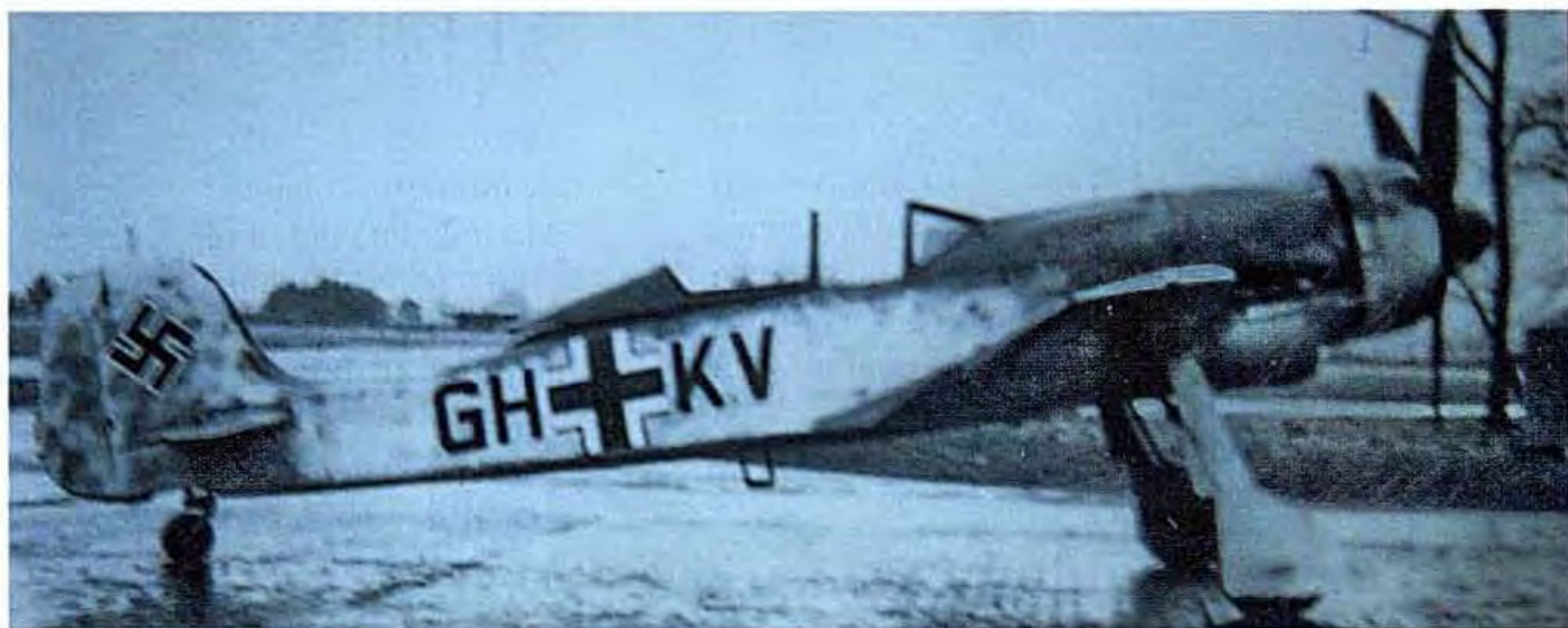
A sinistra: uno dei prototipi del Focke-Wulf Ta.152 (progetto concorrente del BV.155) fu il Fw.190 V30/U1, modificato per rappresentare il Ta.152H. Sotto: la seconda fase dello sviluppo era il Fw.190Ra-4D, poi ridesignato Ta.153; per rappresentarlo fu scelto il prototipo Fw.190 V32; ulteriormente modificato, il GH+KV servì per rappresentare il Ta.152.
