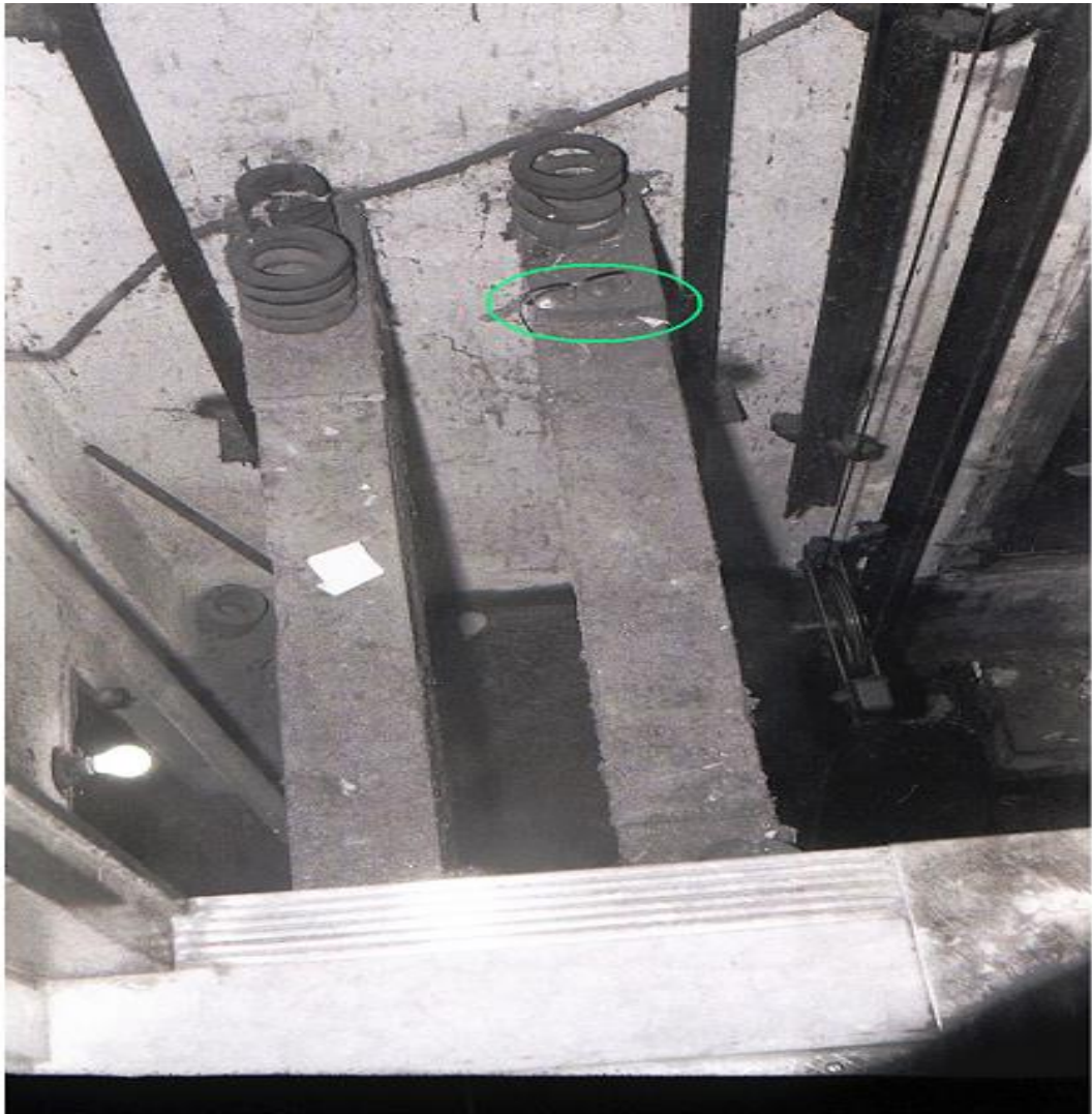
Vista superior das vigas de suporte do elevador social, destacando-se os óculos intactos sobre uma das vigas e a portinhola de acesso ao fundo do fosso
