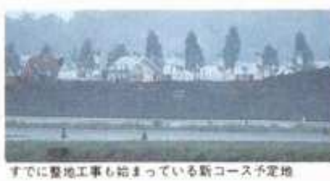
すでに整地工事も始まっている新コース予定地
