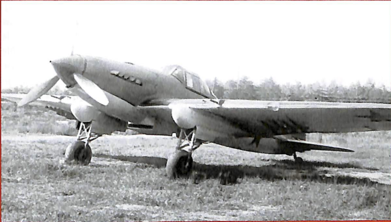
▲ Cet Iliouchine Il-2 Chtourmovik est une version monoplace, armée de deux canons ChVAK de 23 mm, de deux mitrailleuses ChKAS et de huit roquettes. Collection O. Rastrenin
