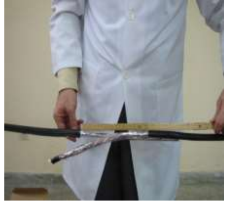
Kablo kılıfları çıkarıldıktan sonra ek açıklığı ve ekleme payını görüyorsunuz.
