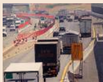
Lavori in corso. Cantiere autostradale
