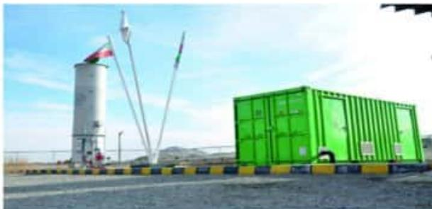
در مرحله بعد گاز فشاردار به سوله مجاور کانتینر که همان نیروگاه کوچک تولید برق است انتقال می یابد و وارد مولد می شود. از سوختن گاز، برق به دست می آید.
