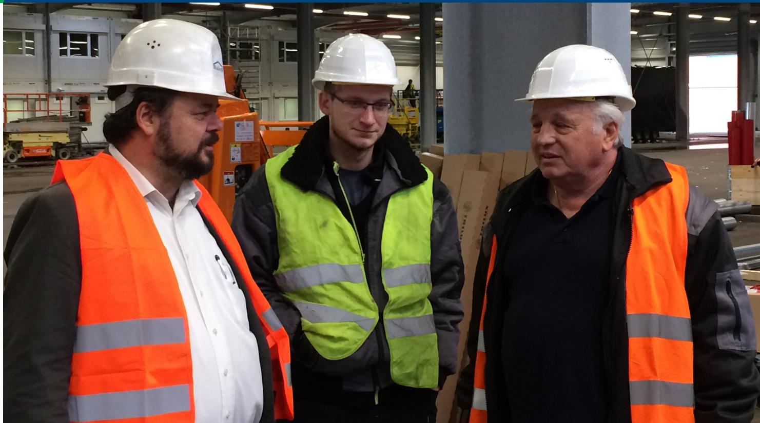
Arbeitet bislang vor allem für Automobilhersteller, Logistiker und einen französischen Alu-Hersteller: Rainer Nobereit (l.) im Oktober in Wackersdorf mit Monteuren, die binnen Wochen eine mobile Halle für BMW errichten. FOTO: FROMM
