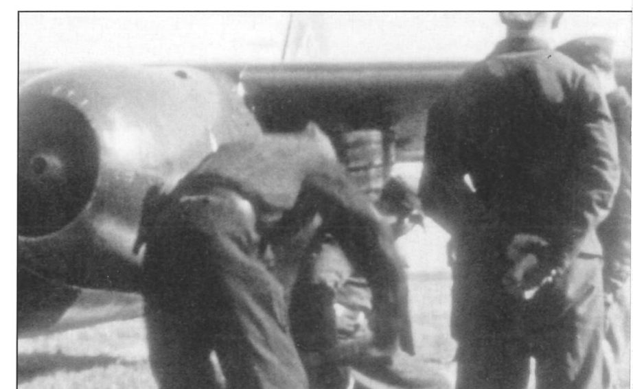
Ci-dessus et ci-dessous : l'Arado 234 V7 T9+MH en train d'être surélevé pour pouvoir placer en dessous son chariot de décollage. Le problème majeur avec les prototypes de l'Arado 234 résidait dans le fait de devoir décoller d'une piste dure et atterrir sur de l'herbe. Dépourvu de train d'atterrissage à roues et seulement équipé d'un train à patin, l'Arado 234 devait être déplacé de son alvéole à la piste d'envol sur son chariot tricyle. Une fois atterri sur l'herbe, l'appareil devait être à nouveau surélevé pour pouvoir replacer en dessous le chariot. L'appareil demeurait alors vulnérable à des attaques aériennes pendant au moins les vingt minutes que durait la manœuvre du personnel au sol. A noter ci-dessous, le cric à base utilisé pour la queue de l'appareil. (Collection Erich Sommer.)
