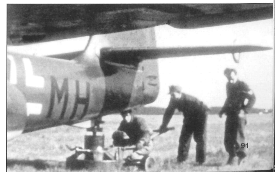
Ci-dessus et ci-dessous : l'Arado 234 V7 T9+MH en train d'être surélevé pour pouvoir placer en dessous son chariot de décollage. Le problème majeur avec les prototypes de l'Arado 234 résidait dans le fait de devoir décoller d'une piste dure et atterrir sur de l'herbe. Dépourvu de train d'atterrissage à roues et seulement équipé d'un train à patin, l'Arado 234 devait être déplacé de son alvéole à la piste d'envol sur son chariot tricyle. Une fois atterri sur l'herbe, l'appareil devait être à nouveau surélevé pour pouvoir replacer en dessous le chariot. L'appareil demeurait alors vulnérable à des attaques aériennes pendant au moins les vingt minutes que durait la manœuvre du personnel au sol. A noter ci-dessous, le cric à base utilisé pour la queue de l'appareil. (Collection Erich Sommer.)
