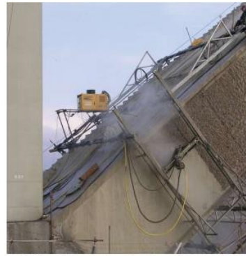
El jetframe trabajando en la estructura del puente KRK. Puente KRK, croacia
