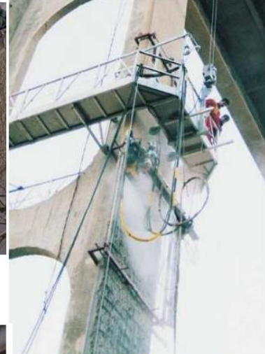
Reparación de un pilar alto KRK. Croacia
