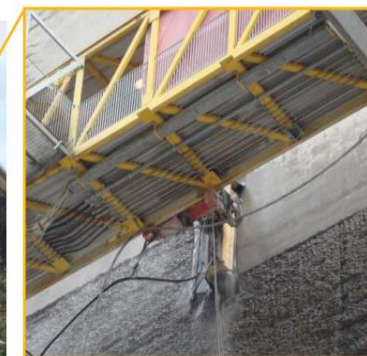
Reparación de un gran pilar de un puente. Viaducto de Río Verde, Italia
