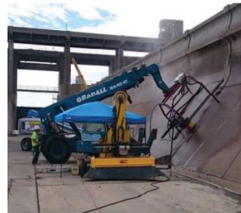
Renovación de las paredes en una planta de energía hidráulica usando el robot 367 como unidad de control. Montana. USA
