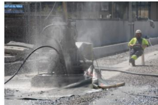
El robot removiendo el concreto de un puente Stocolmo, Suecia
