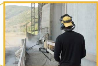
Robot operando en la plataforma, removiendo concreto de la estructura de un puente. L'Aquila, Italy.
