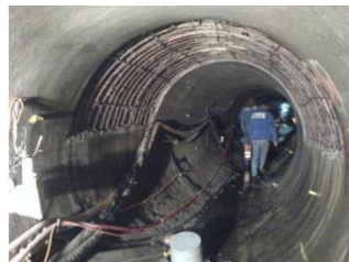
Resultado de la hidrodemolición con el robot en el túnel. Zurich, Suiza
