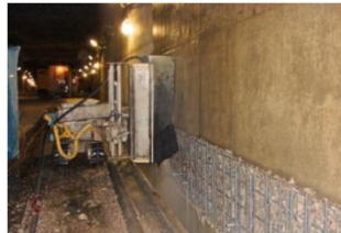
Robot removiendo el concreto de la pared de un túnel. Stocolmo, Suecia.
