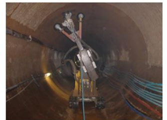
El robot en un túnel de aguas residuales Paris, Francia.
