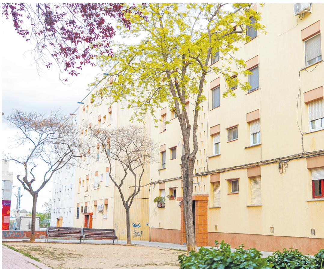
Blocs de pisos de les Termes, en una imatge d'arxiu / AINATORES
