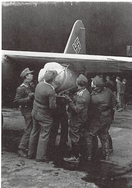
Mise en place d'un accélérateur sous l'aile d'un Arado 234B. Le parachute de récupération était replié à l'avant du conteneur.
