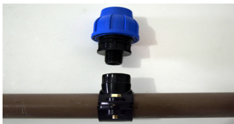
Figura 10: Conectar adaptador no colar
