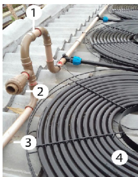
Figura 11: Instalação conjunta válvula “quebra-vácuo”
