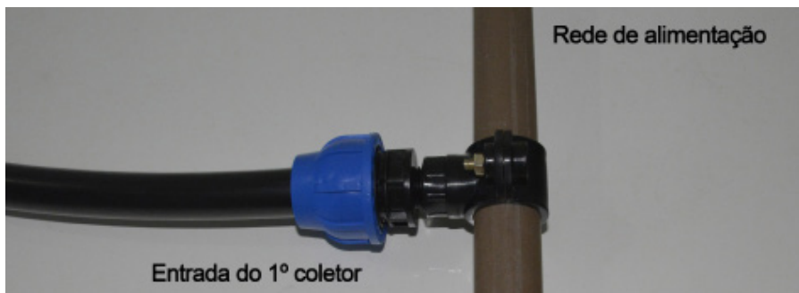
Figura 7: Adaptador unindo entrada dos coletores à rede de alimentação
