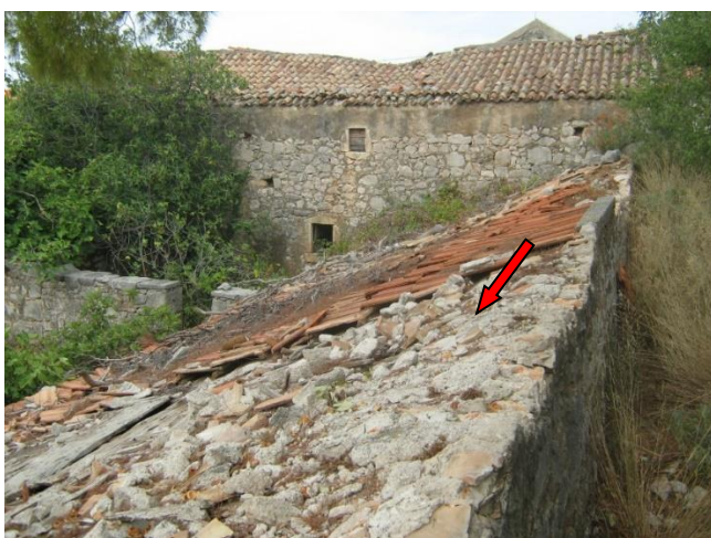
Slika 54. Pogled na dio objekata u brdo ukopanih ispod sjevernog obrambenog bedema. Strelica pokazuje krov nadstrešnice ispod obrambenog bedema.
