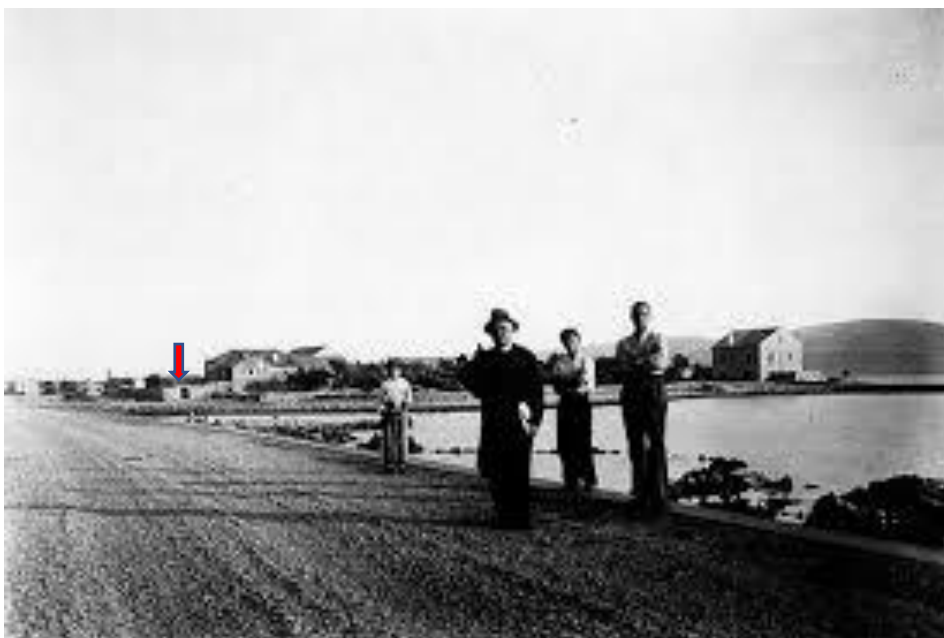
Slika 26. Pogled sa zapadne strane na kuće i Župni dvor na Punt. Slika je nastala poslije izgradnje makadamske ceste Obrovac – Karlobag, 1937. godine [8]. Na slici je don Ante Adžija sa još tri osobe.
