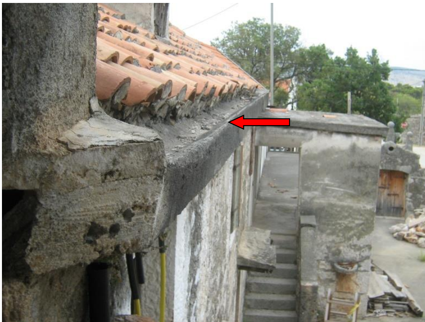
Slika 57. Žlijeb ispod strehe krovišta pokrivenog kupom kanalicom, koji je služio za hvatanje i odvođenje kišnice u gusternu.
