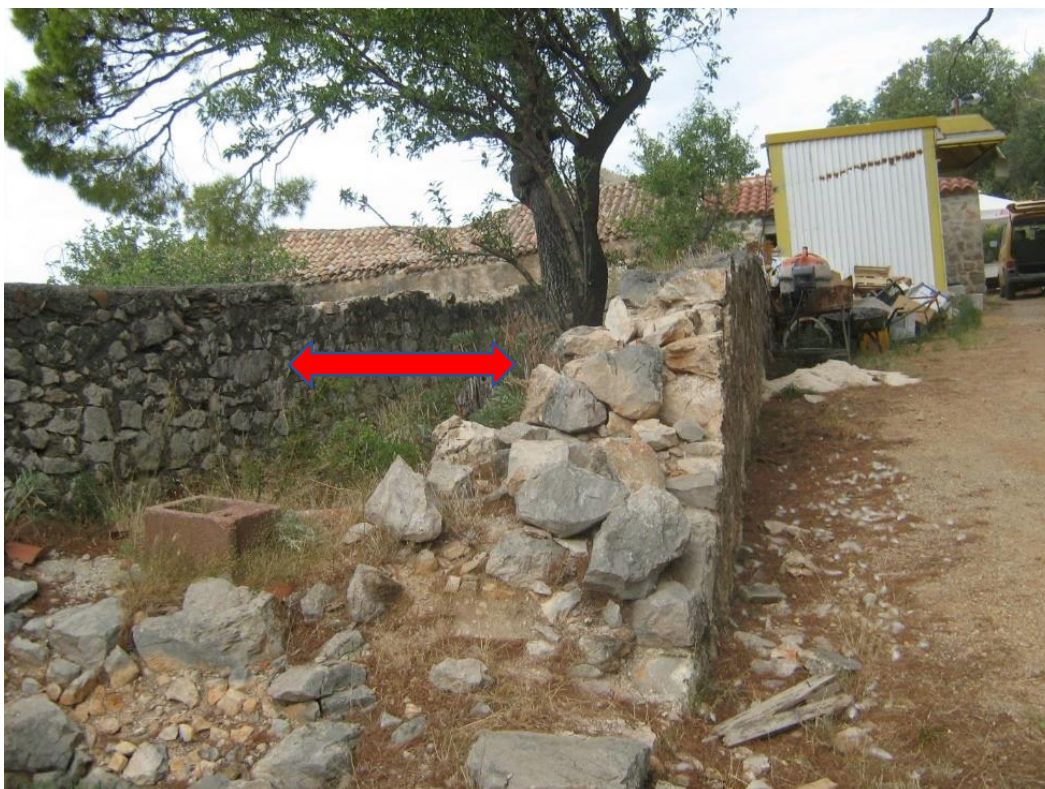
Slika 37. Pogled s istočne strane na ulaz u koridor za kretanje stražara. Vanjski (desni) zid koridora je devastiran. U pozadini je kontejner i omanja zgrada kao dodatci taverne-konobe „Marasović”, 2018.
