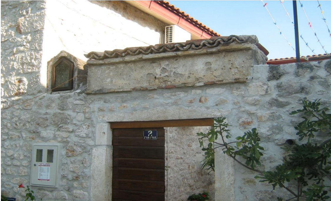
Slika 17. Da je ova zgrada imala veći značaj od ostalih zgrada na Puntiću može se zaključiti po nadvoju i kapelici iznad ulaznih vrata u njeno dvorište (svojevrsni klaustar), po zatvorenom dvorištu i po gusterni velike zapremine koja se nalazi u dvorištu, s desne strane od ulaznih vrata.
