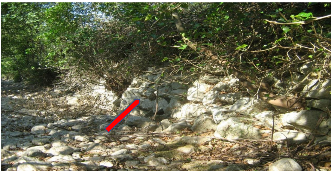
Slika 74. Zapuštenu zapadnu obaloutvrdu ponornice Velika Paklenica uzidana kamenom, 2017.
