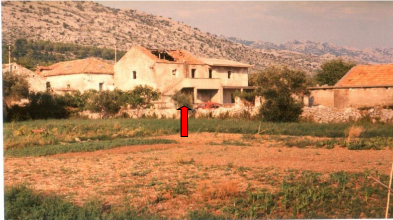
Slika 22. Ruševna zgrada snimljena 1996. godine u kojoj je radila Pučka škola sve do dovršetka nove školske zgrade, 1952. godine.
