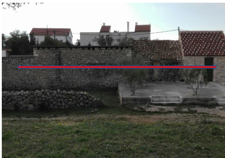
Slika 24. Na udaljenosti od oko 3 - 4 metra od sjeverne strane obrambenog bedema naknadno je složen suhozid.
