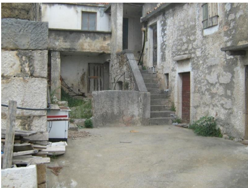
Slika 56. Stepenište koje vodi na gornju etažu zgrade. S desne strane od stepeništa je grlo gusterne, a ispod grla je gusterna velike zapremine.
