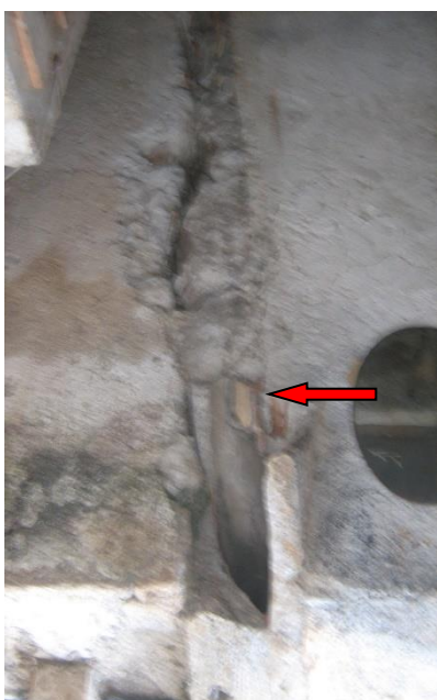
Slika 58. Ostaci vertikalnog kanala ugrađenog u zid zgrade s kojom je kišnica upuštana u gusternu.
