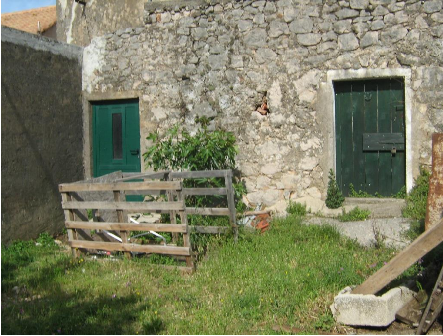
Slika 43. Sjeverna zgrada na istočnoj strani utvrde, koja je fizički spojena sa zadnjom zgradom na toj strani, ali je istočno od nje.
