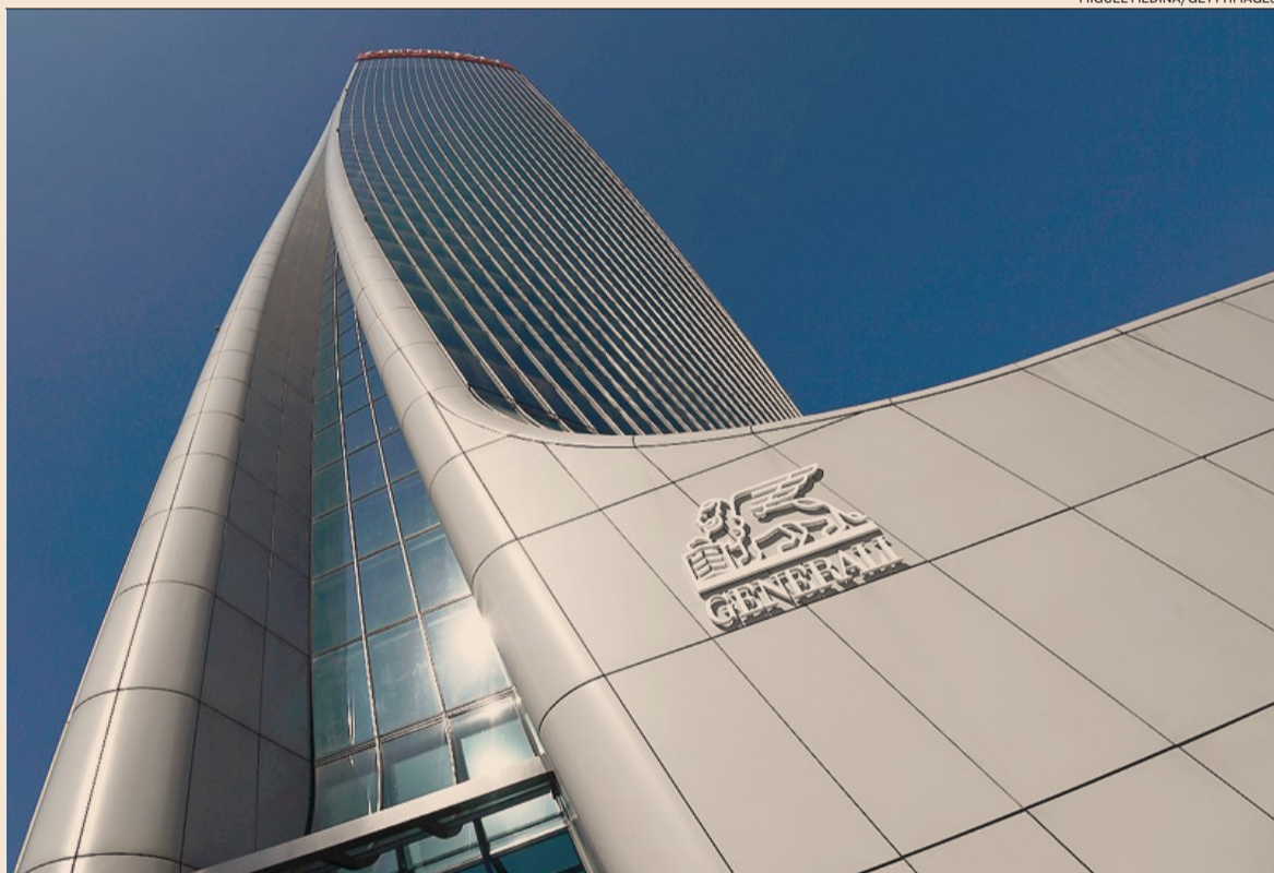
Assicurazioni. La Torre Generali a Milano City Life progettata da Zaha Hadid: 43 piani e 177 metri di altezza
