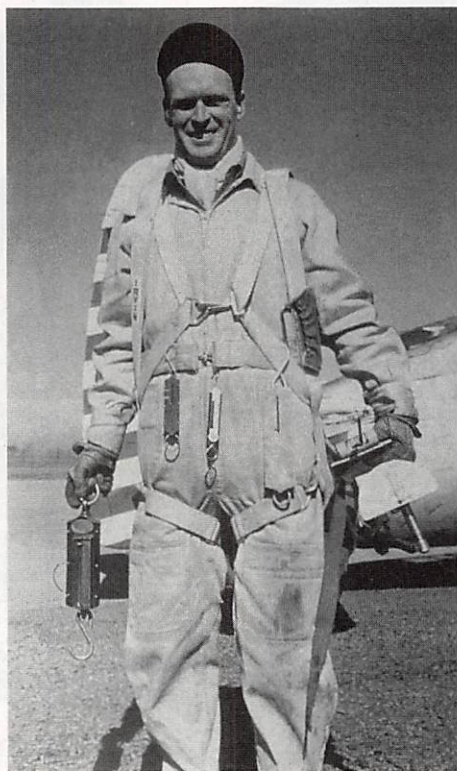
Le pilote d'essais de l'usine, Red Hulse, avec ses outils : des dynamomètres pour mesurer les efforts sur le manche, en mai 1941.
