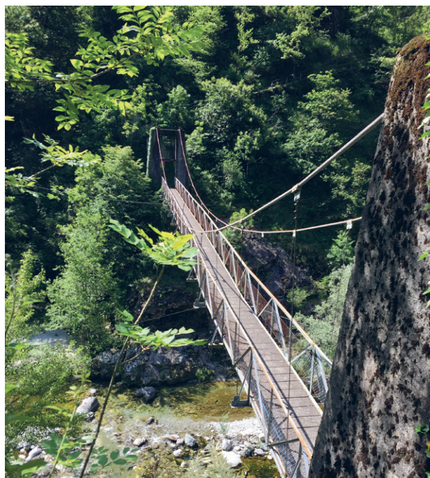
La Melezza con il ponte sospeso sotto Corcapolo costruito nel 1871 e riattato nel 1978
