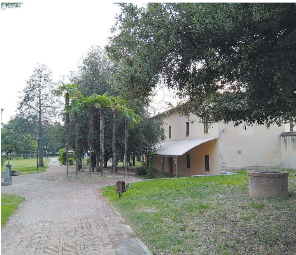
La struttura La costruzione in muratura si trova agli Orti Orfini e potrebbe diventare la sede del Centro sociale
