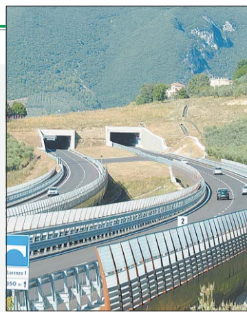
Viabilità | I lavori partono da lunedì
