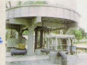
Vista General de la Planta de Tratamiento
