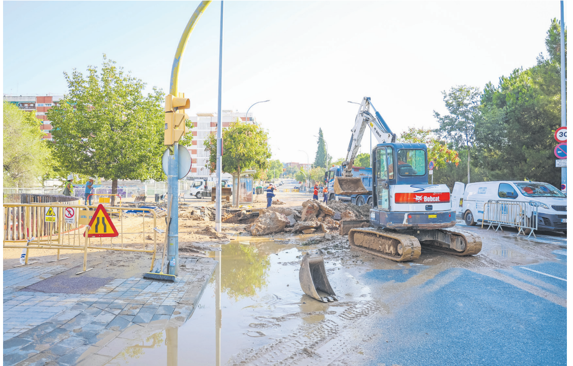
Els treballs de reparació, unes hores després de l'incident / VÍCTOR CASTILLO
