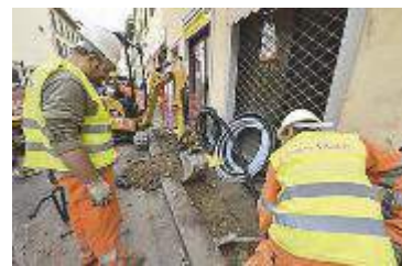
Lavori per la rete
