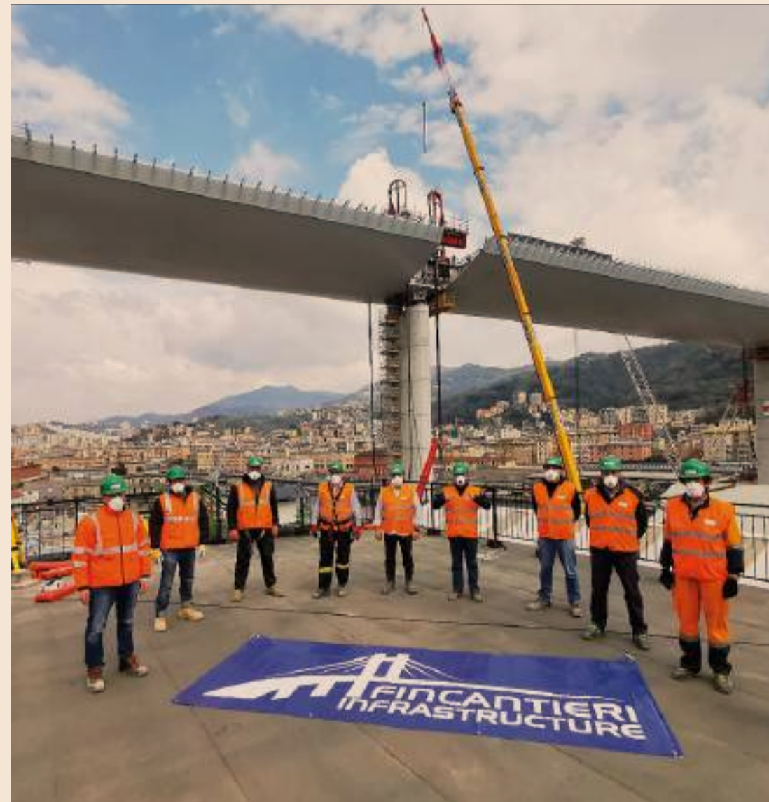
Costruzione e gestione. Inso porterà in dote a Fincantieri Infrastructure anche la manutenzione di grandi edifici
