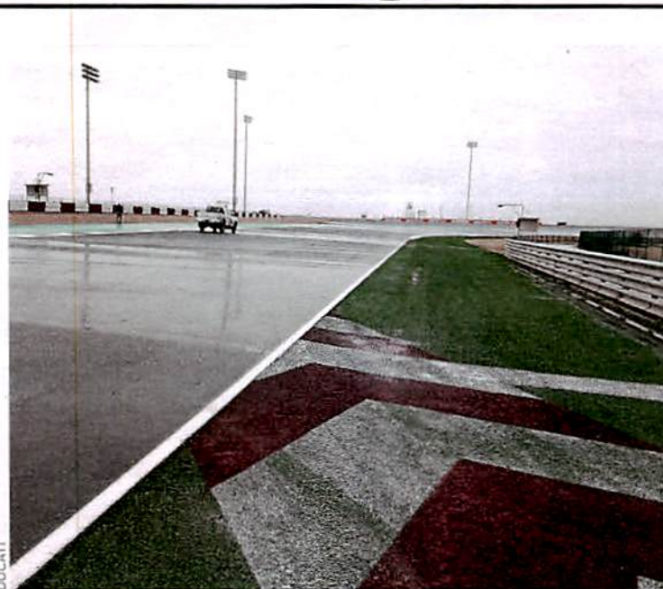
Vor uns die Sintflut: Ohne Drainage liefen ständig Bäche über die Piste
