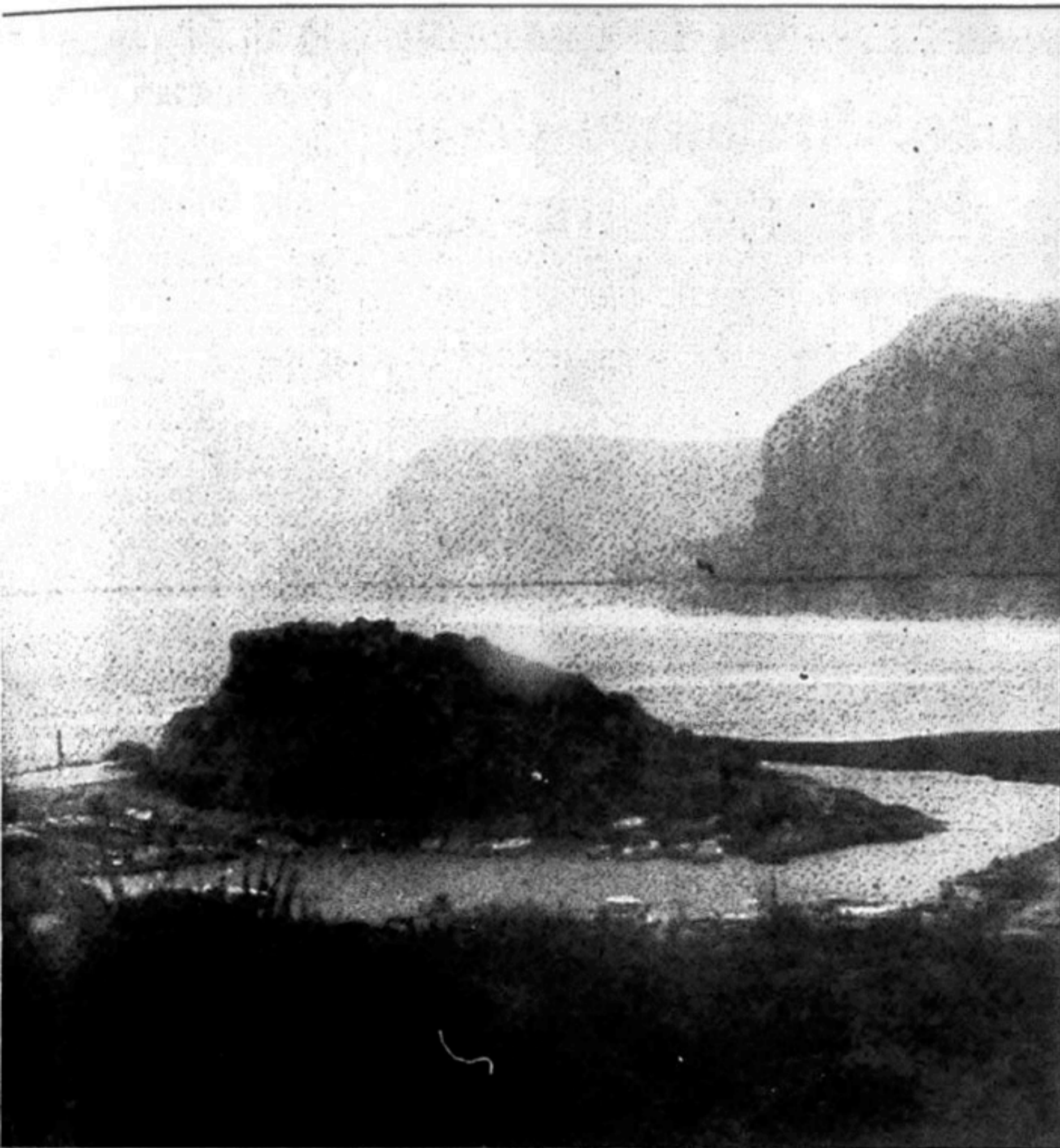
el aspecto actual, supondrá la creación de una playa estable y la recuperación de la línea de costa de 1957.
