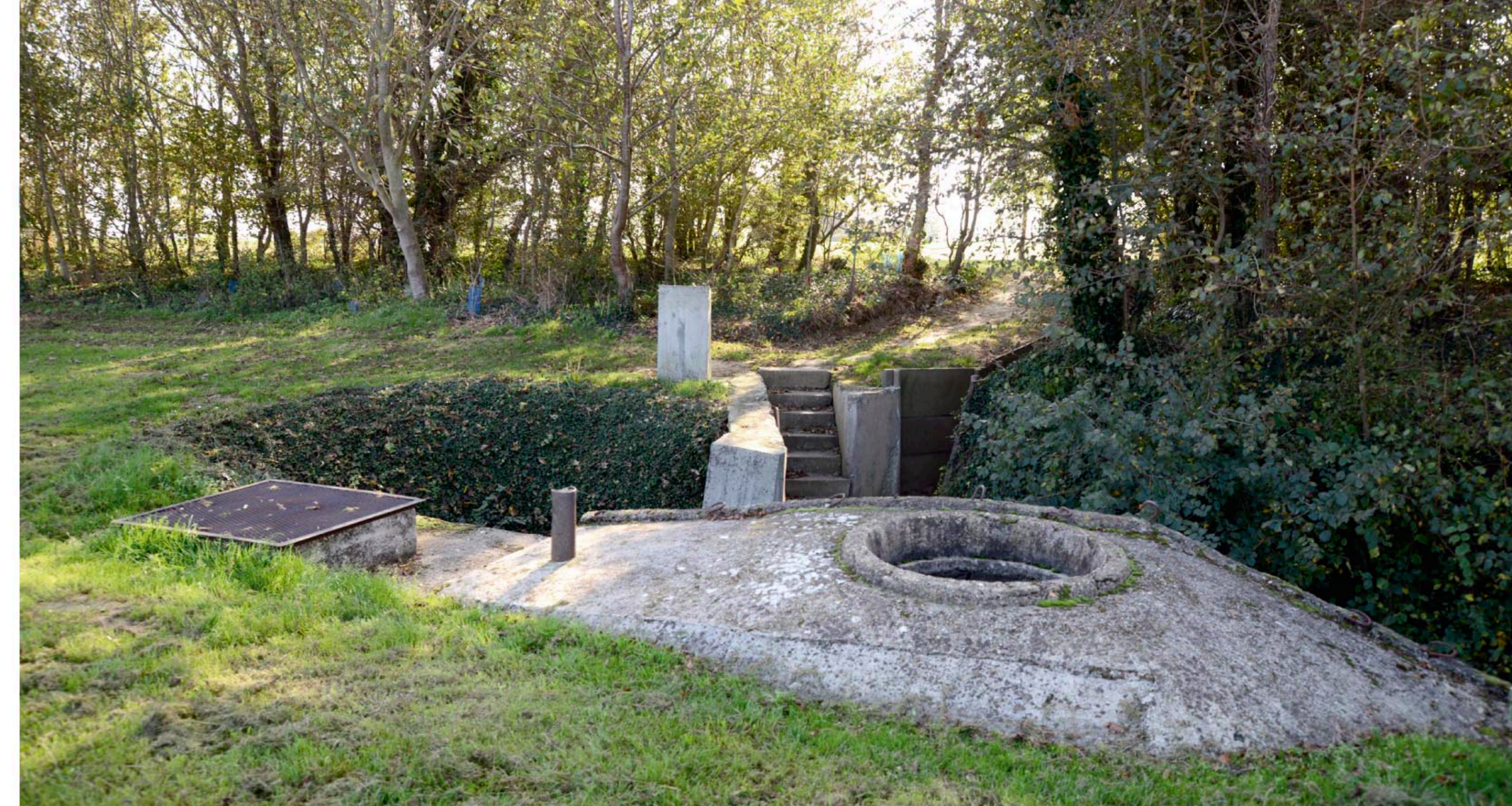
En haut : le poste de commandement B. Ce blockhaus est semblable au poste de commandement A, exceptée la coupole de forme différente et accessible par un couloir souterrain plus long. La construction de cet ouvrage a nécessité l'extraction d'environ 1950 m 3 de terre et l'utilisation de 990 m 3 de béton et de 45 tonnes d'acier. Cet ouvrage fortifié aurait été utilisé également comme un bâtiment administratif.
