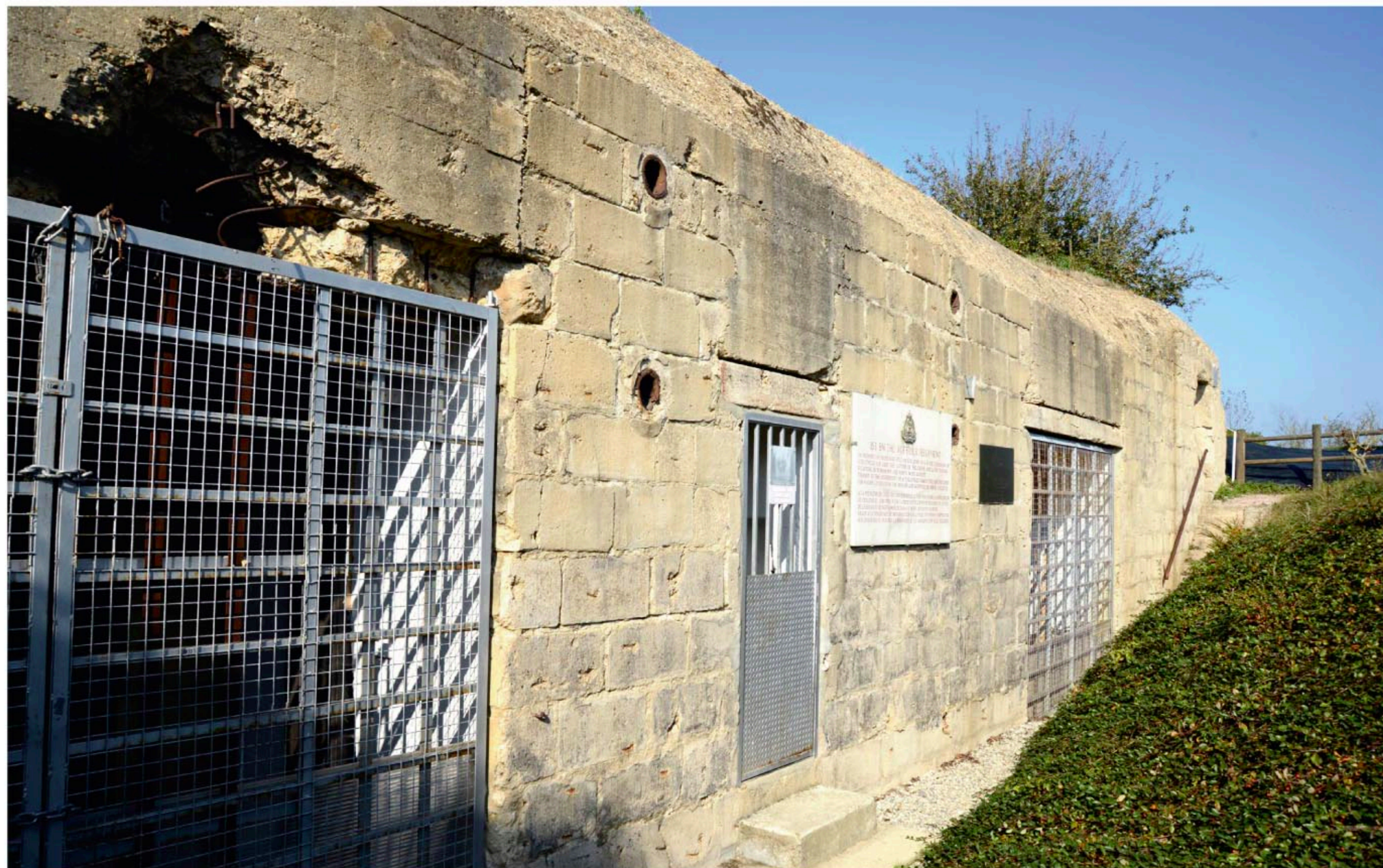
Cet abri bétonné n'est pas achevé au matin du 6 juin 1944. Il devait servir de garage pour un canon antichar ou pour un véhicule. Les portes coulissantes blindées n'ont jamais pu être posées. Il ne reste en Europe que cinq exemplaires de ce type rare de construction du « mur de l'Atlantique », dont deux modèles en France.
