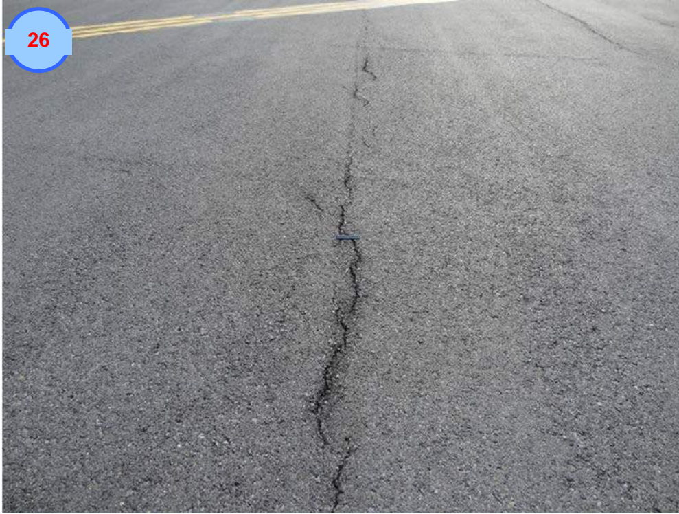
Longitudinal Cracking
