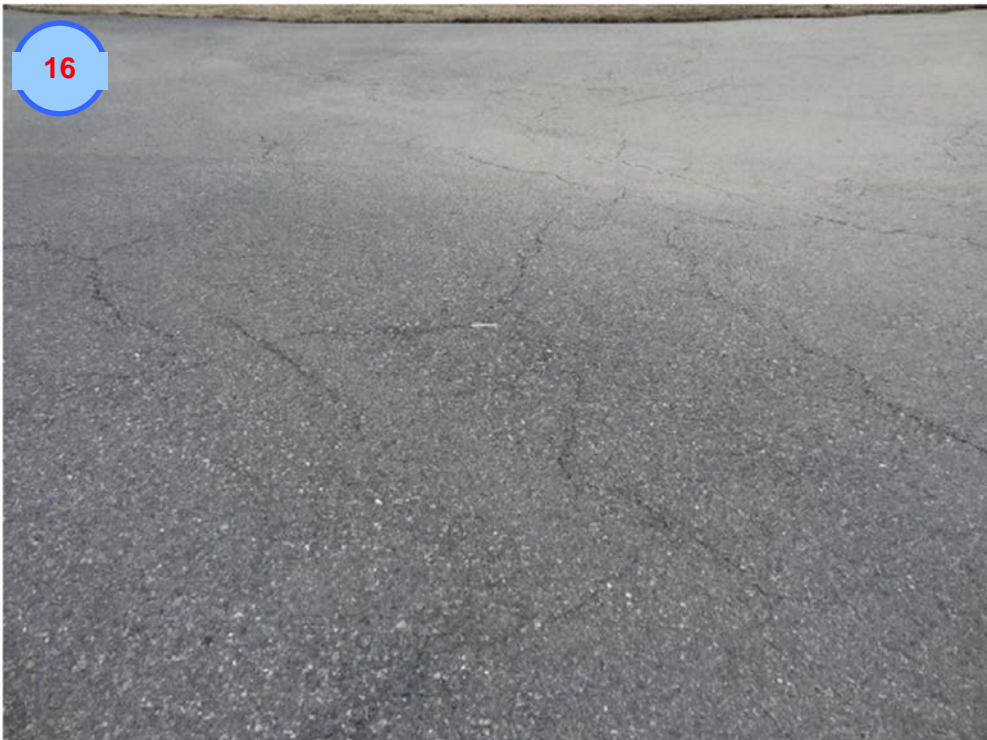
Longitudinal Cracking
