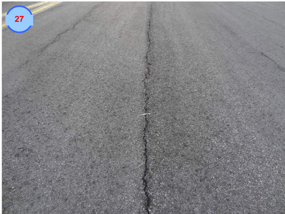
Longitudinal Cracking
