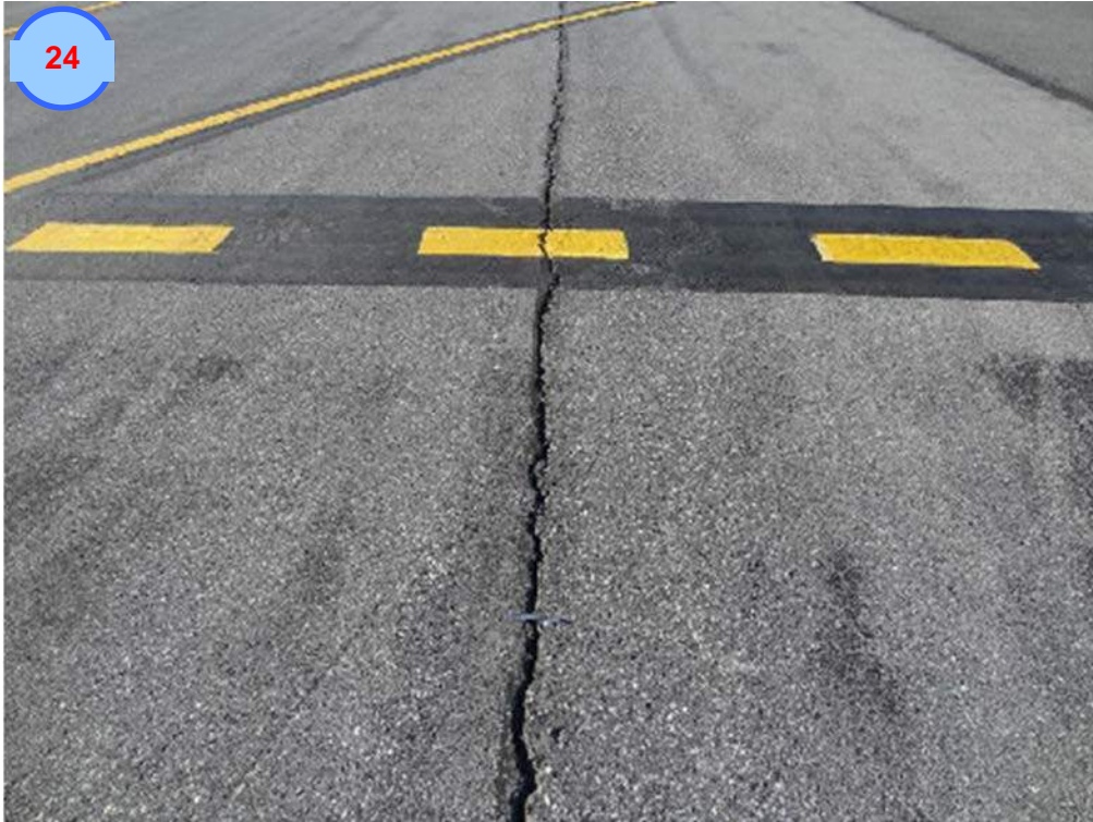
Longitudinal Cracking
