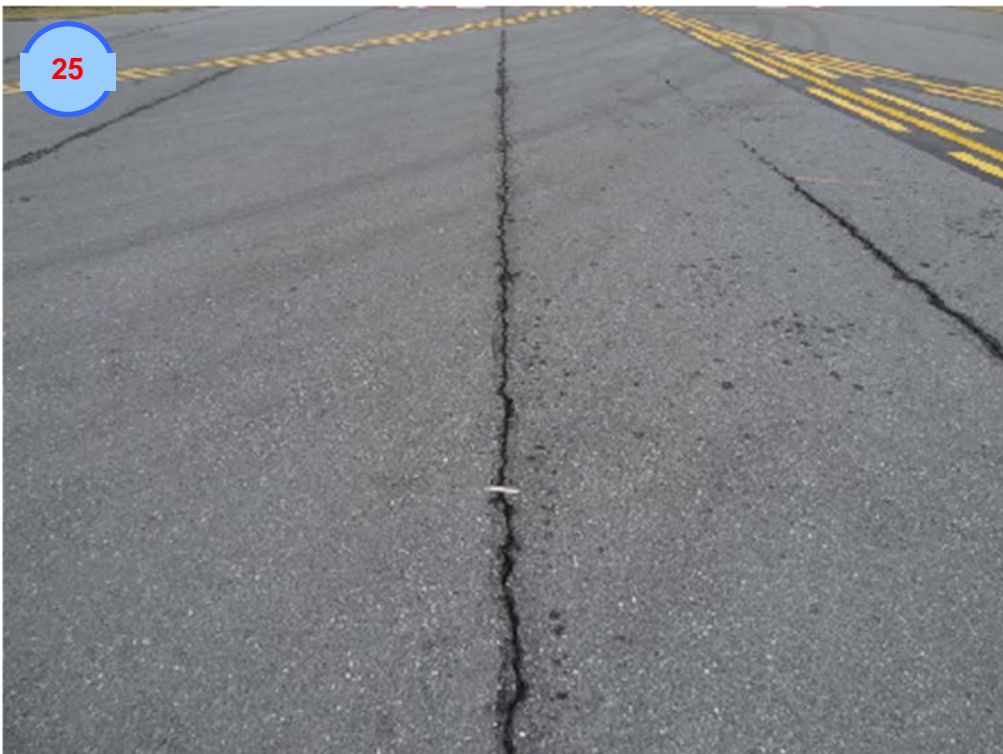
Longitudinal Cracking
