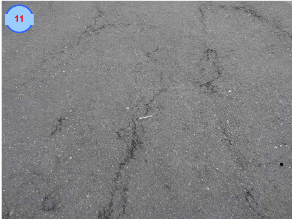
Longitudinal Cracking
