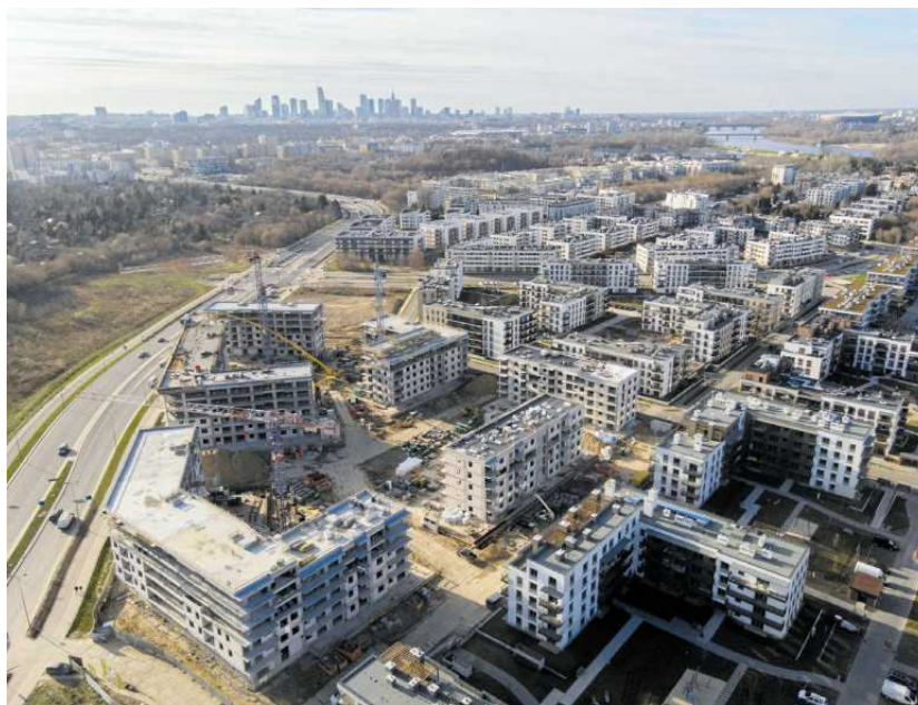
• Budowa nowych osiedli w Warszawie, marzec 2023 r.
