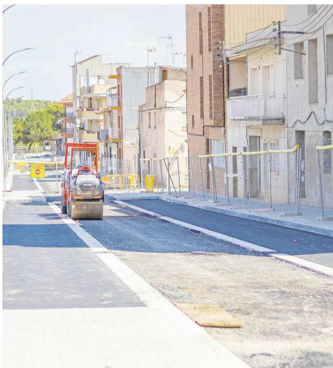
Obres d'asfaltatge al carrer del Caucas / AINATORRES
