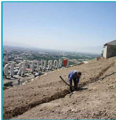
حفاری، لوله اندازی و راه اندازی شبکه آبیاری تحت فشار به مترائز ۱۰۰ متر
