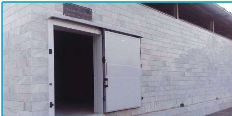
نماکاری دیوار خارجی سالن پیش سردکن کشتارگاه
