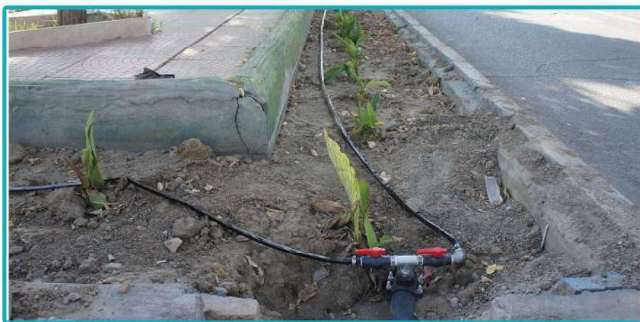
نصب نوار تیپ زیپدار به طول ۴۰۰۰ متر
