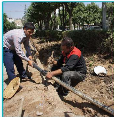
اجرای حفاری، لوله اندازی و راه اندازی سیستم آبیاری تحت فشار به طول ۲۰۰۰ متر
