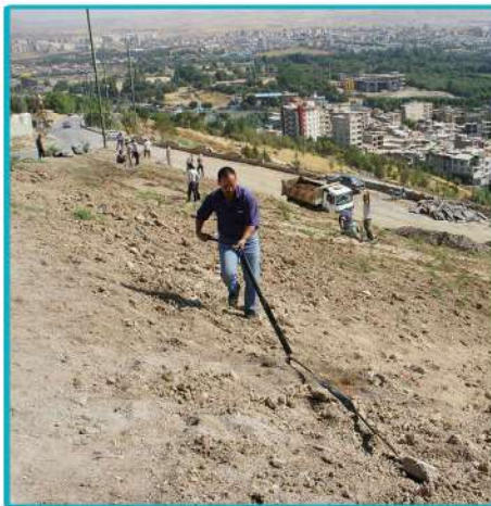
حفاری، لوله اندازی و راه اندازی شبکه آبیاری تحت فشار به مترائز ۱۰۰ متر
