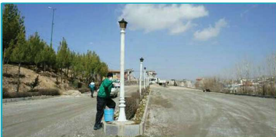
جانمایی و نصب چراغ های زینتی در مسیر ورودی خط تله سیژ تپه شهدا
