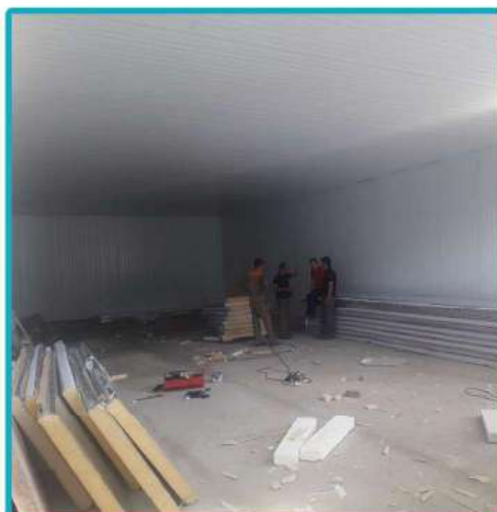
نصب پنل های داخلی بر روی دیوارهای سالن های پیش سردکن کشتارگاه
