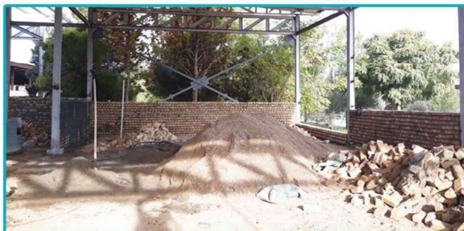
احداث سالن بسته بندی گوشت (در مرحله دیوارکشی)
