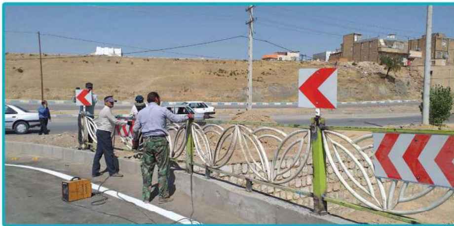
نصب علائم ترافیکی تکمیلی بر روی نرده های جدید پل ورودی کوی پزشکان
