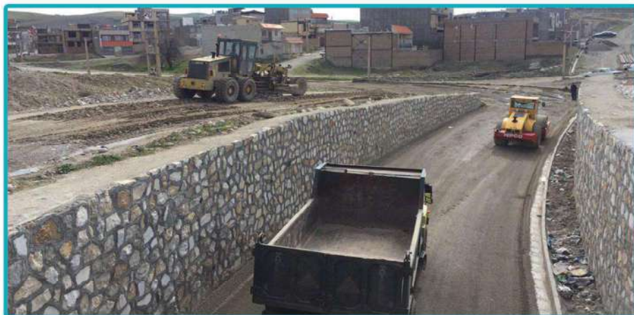
تسطیح و کوبیدن روگذر و زیرگذر پل ورودی شهرک نیاوران
