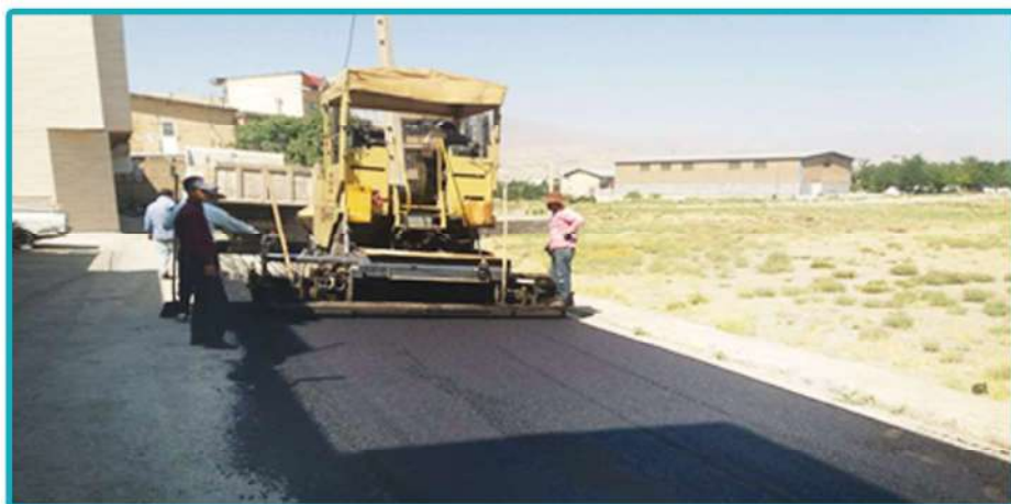
اجرای آسفالت کوچه سوسن واقع در خیابان علی آباد به مترآژ ۳۵۰۰ مترمربع
