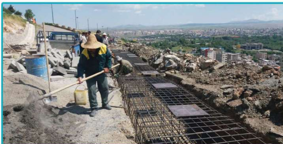
خاکبرداری و پی کنی و آرماتور بندی
