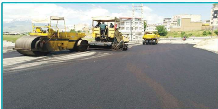
اجرای روسازی و آسفالت روگذر و زیرگذر پل ورودی شهرک نیاوران
