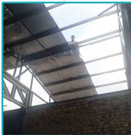
نصب سقف سالن های پیش سردکن و بسته بندی کشتارگاه با نمای شیروانی
