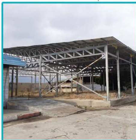
نصب سقف سالن های پیش سردکن و بسته بندی کشتارگاه با نمای شیروانی
