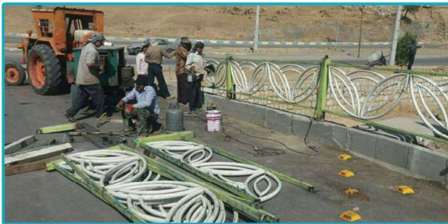
نصب نرده (هندریل) و علائم ترافیکی بر روی پل
