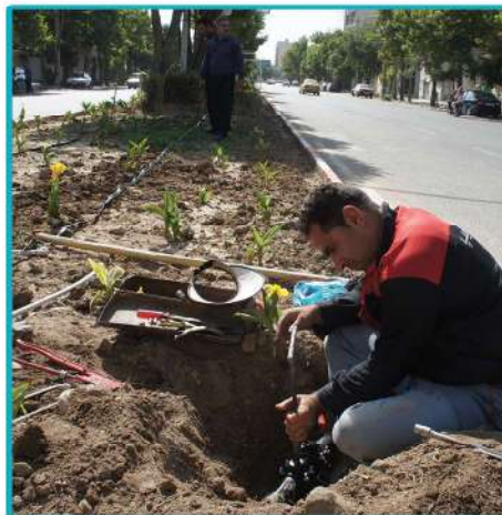
اجرای حفاری، لوله اندازی و راه اندازی سیستم آبیاری تحت فشار به طول ۲۰۰۰ متر
