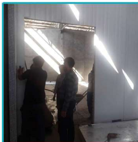
نصب پنل های داخلی بر روی دیوارهای سالن های پیش سردکن کشتارگاه
