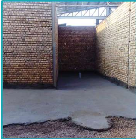
اجرای بتن مگر، بتن آرمه کف و آرماتوربندی سالن های پیش سردکن کشتارگاه
