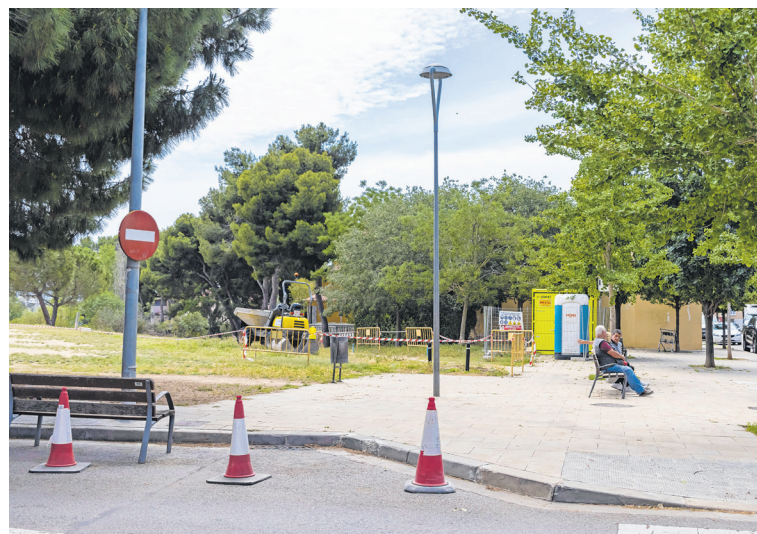
Les excavadores ja treballen en la rehabilitació del camí / AINA TORRES
