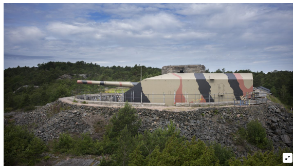
Skytset har blitt pusset skikkelig opp for første gang siden kystfestningen på Møvig ble nedlagt i 1952. Foto: Karan Bjelland
