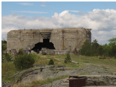
Det var fra i kasematten de opprinnlige kamouflasjefargene ble funnet.
