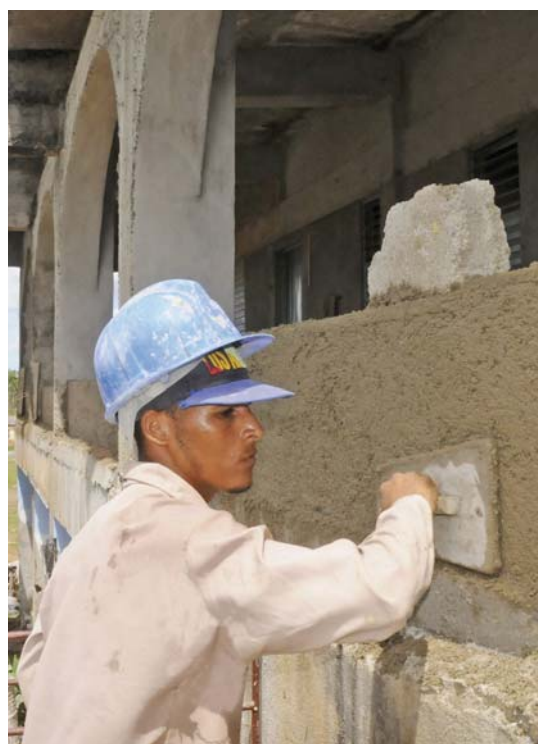
Los 40 constructores de la brigada de viviendas de la Empresa Guanaco terminarán este mes las últimas cuatro casas adecuadas de este bloque.
