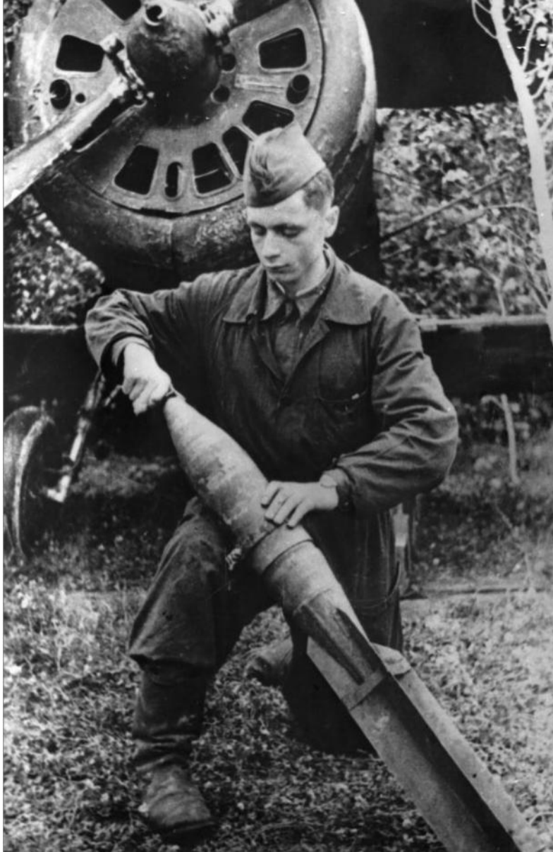
Réglage sur une bombe avant son chargement sur un I-153 ; l'avion pouvait emporter plusieurs types de bombes.
